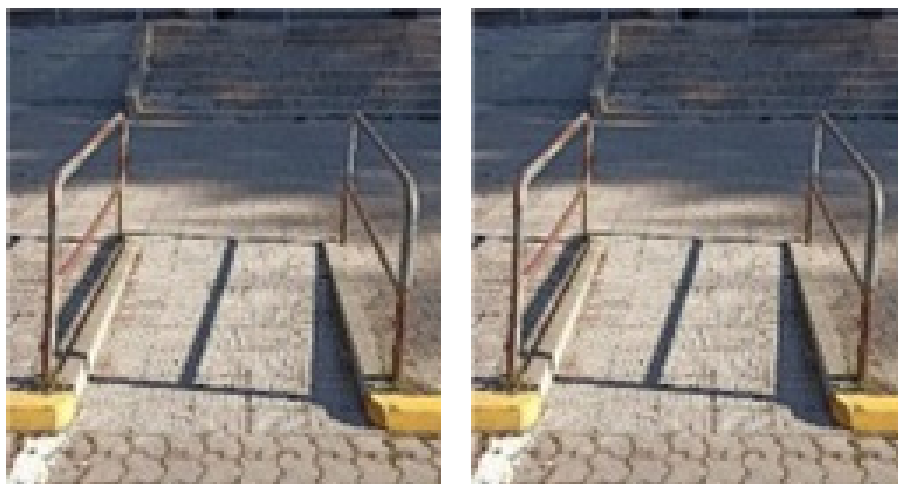
Figura 4. Rampa de acceso del itinerario peatonal al itinerario de la calzada
