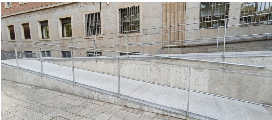
Figura 3. Rampa de acceso al edificio
