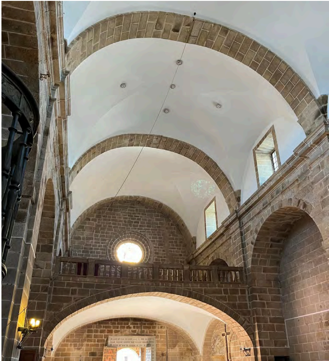
Figura 64. Interior hacía el coro y sotacoro de la iglesia de Santa María de Almocóvar.
