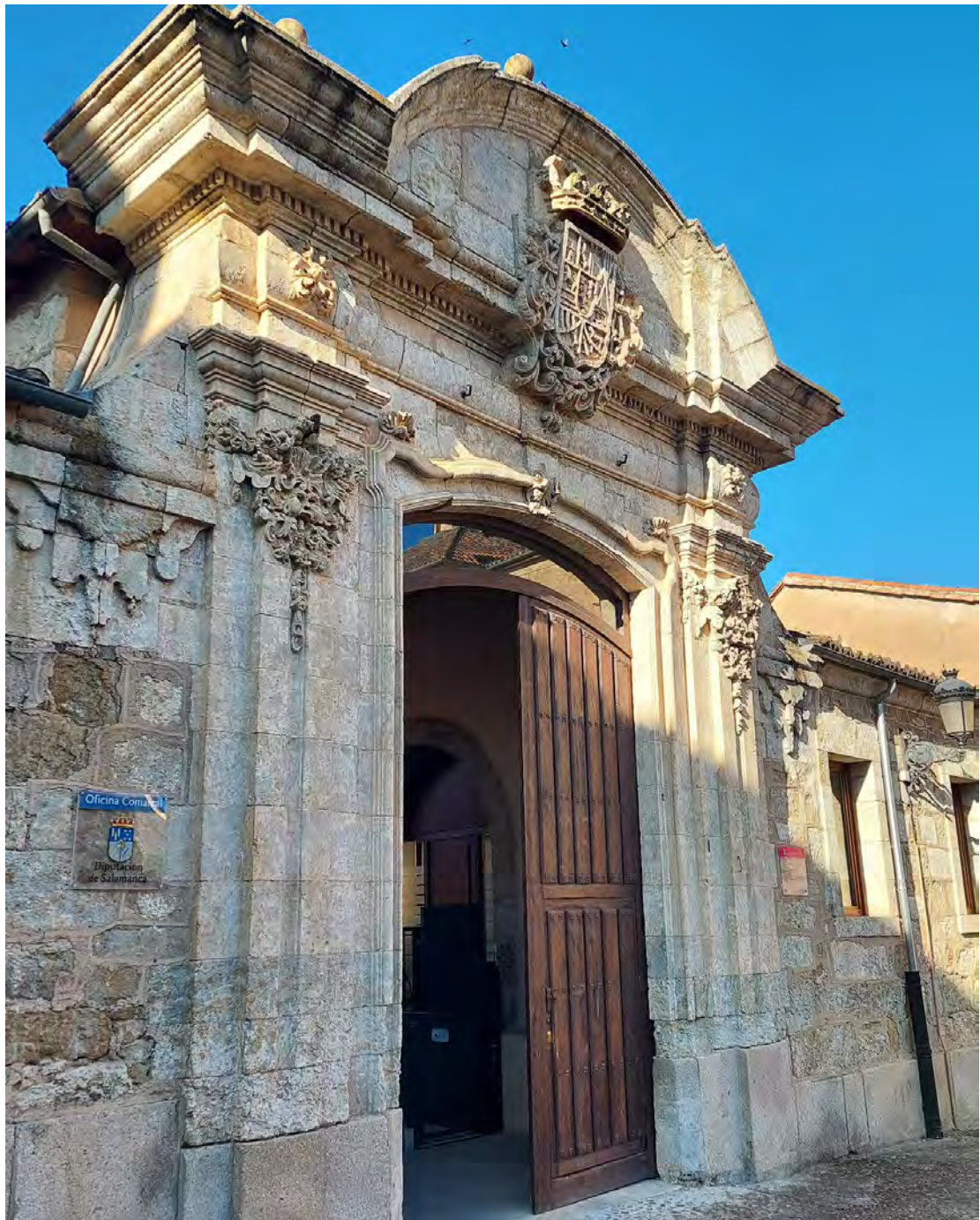
Figura 122. Fachada del antiguo Arsenal de Ciudad Rodrigo. Fotografía de Víctor González García
