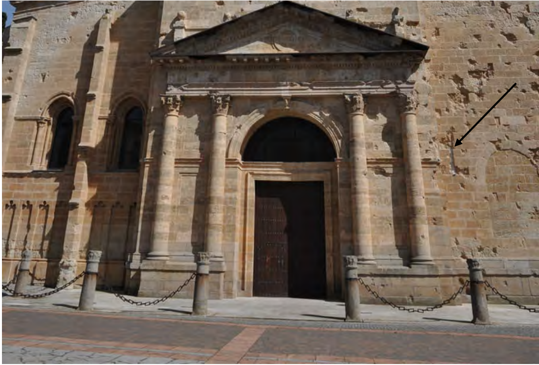
Figura. 5. Muro oeste Fotografía de Víctor González García
