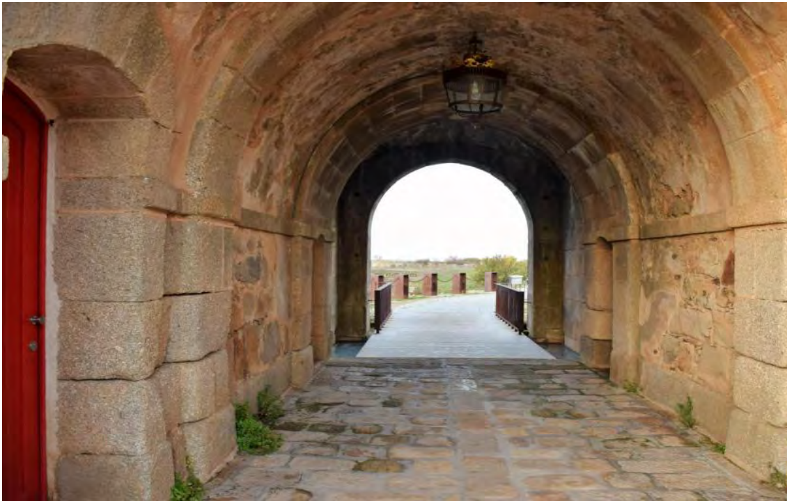
Figura 128. Bóvedas de cañón del interior del cuerpo de entrada del Fuerte de la Concepción de Aldea del Obispo.
