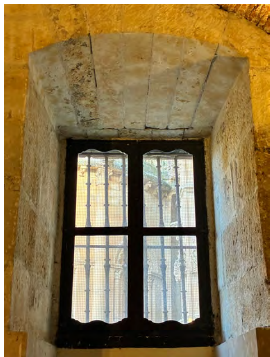
Figura. 26. Ventana en cuarto de sacristán.
