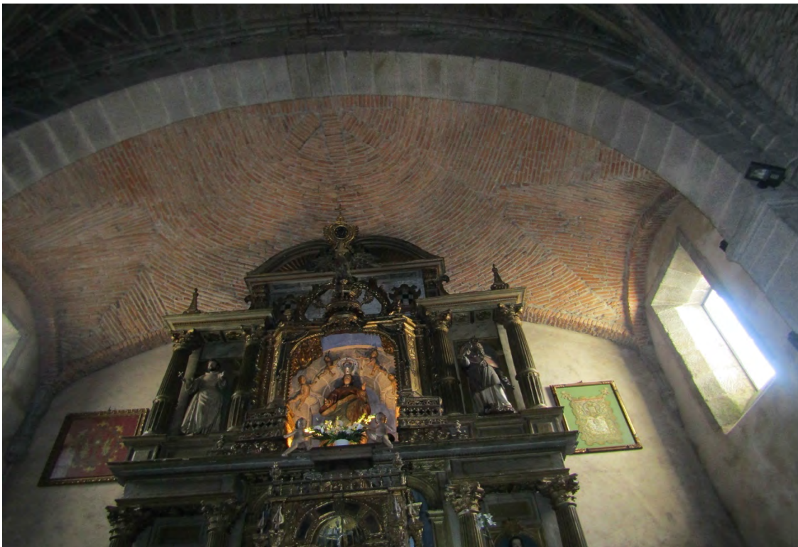
Figura 71. Bóveda de ladrillo en rosca de media naranja o bóveda de ladrillo de hojas en el testero de la iglesia de Santa María de la Asunción de La Alberca.
