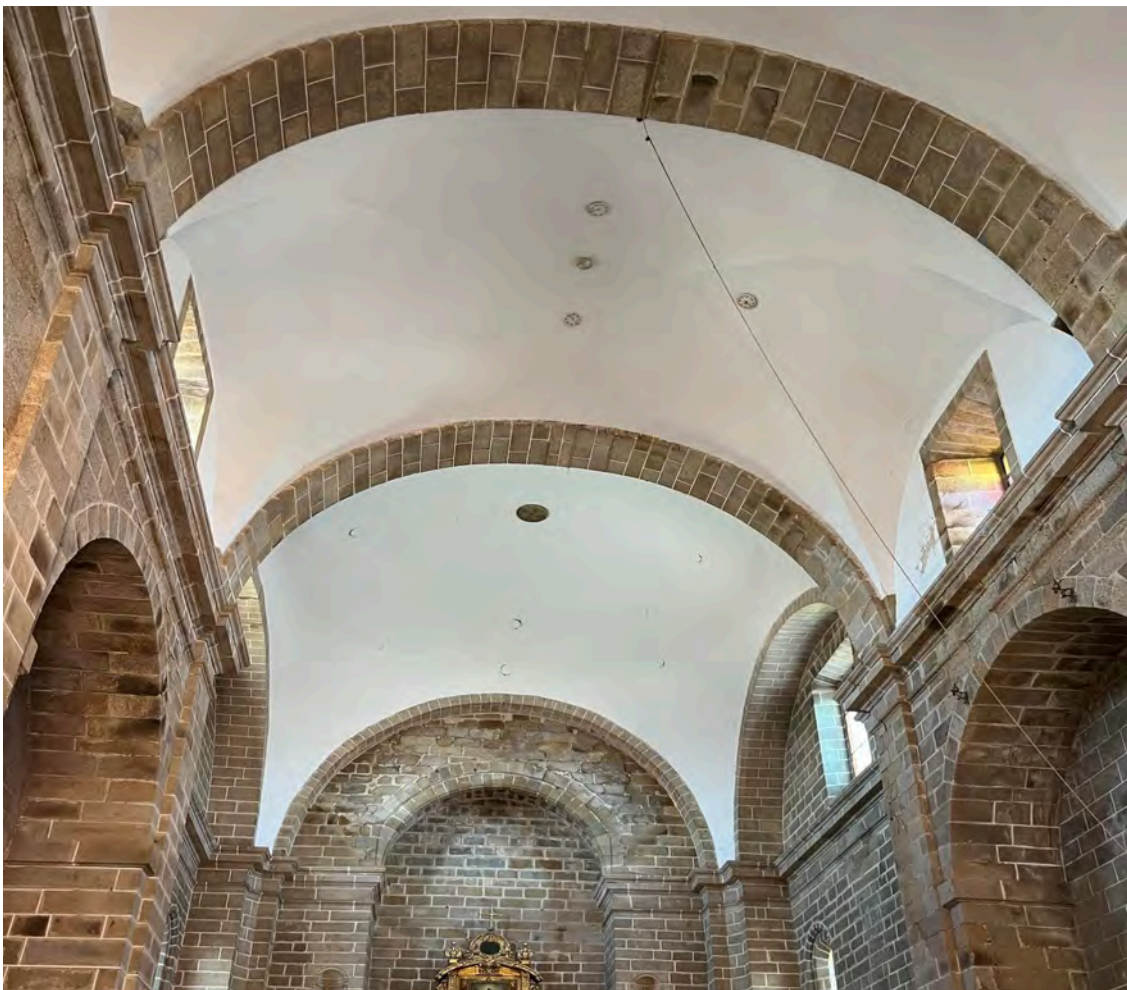
Figura 63. Interior hacía la cabecera de la iglesia de Santa María de Almocóvar.
