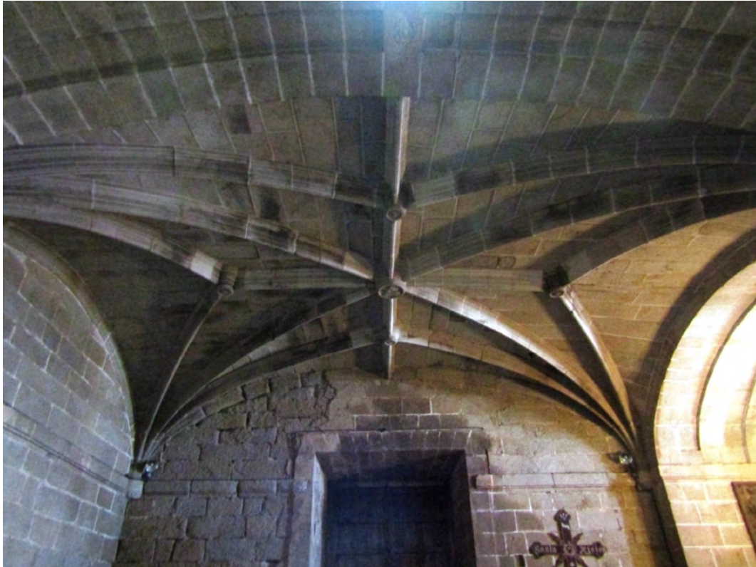
Figura 48. Bóveda de cruceira del sotacoro de la iglesia de San Juan Bautista.
