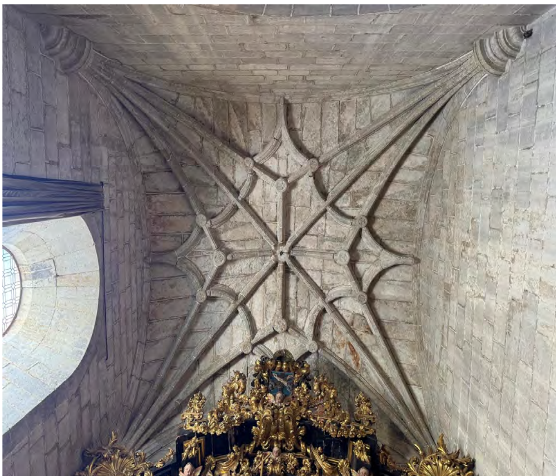
Figura. 7. Bóveda de la capilla de Nuestra Señora de los Dolores.
