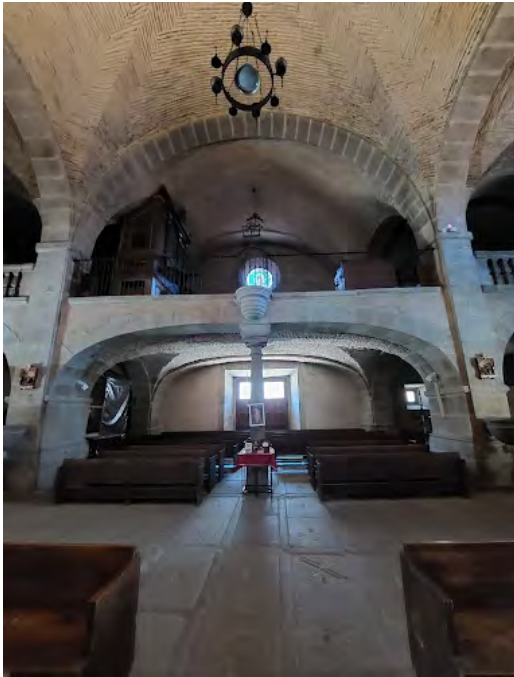
Figura 67. Vista interior hacia el coro y sotacoro de la iglesia de Santa María de la Asunción.
