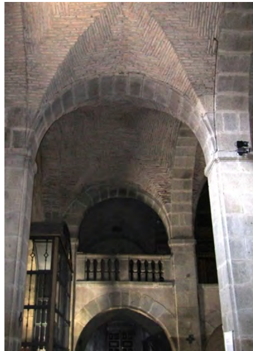
Figura 70. Vista de las bóvedas de la nave del Evangelio de la iglesia de Santa María de la Asunción de La Alberca.
