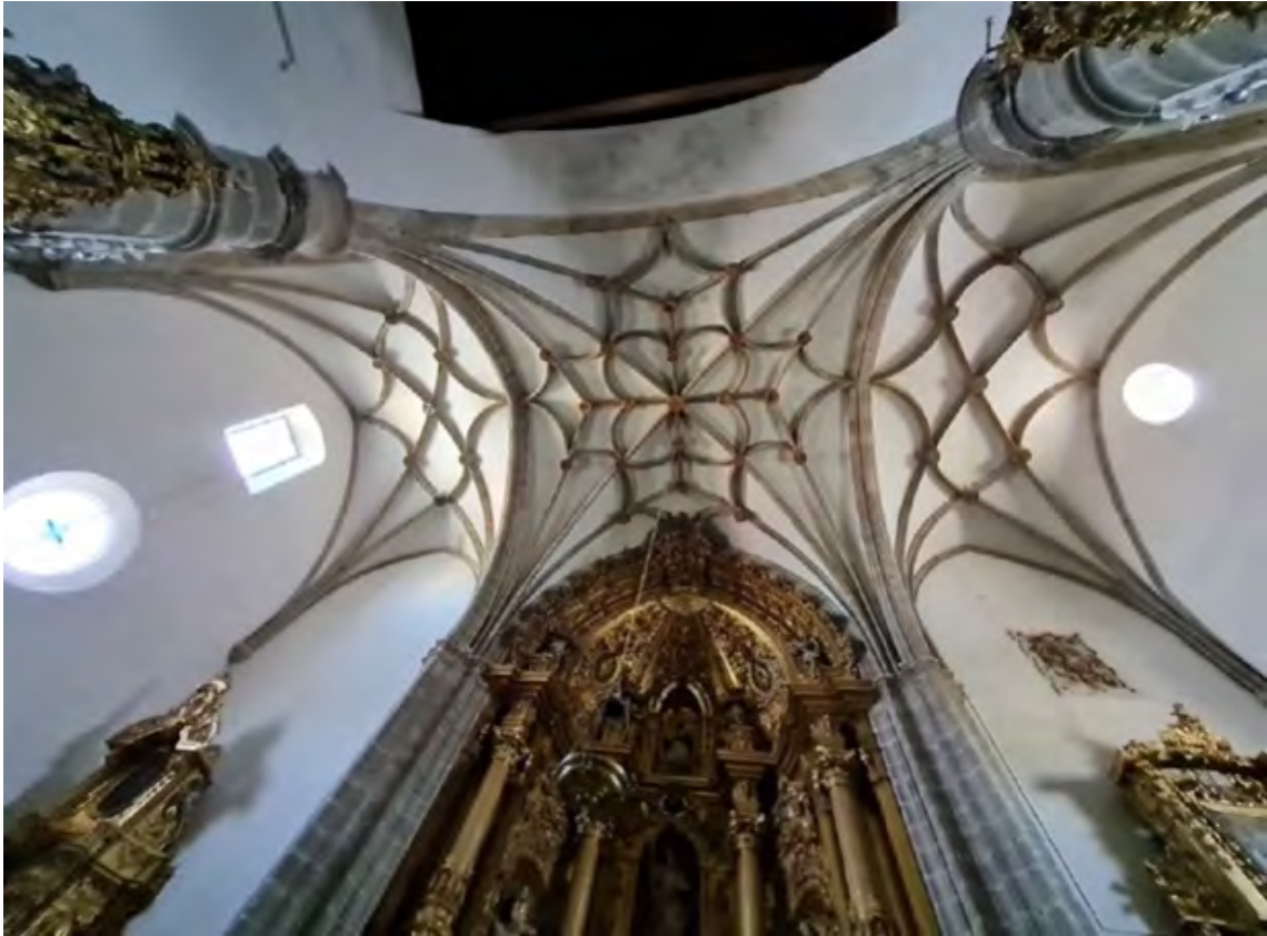
Figura 95. Bóvedas de crucería de la capilla mayor y el crucero de la iglesia de San Cipriano en Fontiveros. Fotografía de Víctor González García
