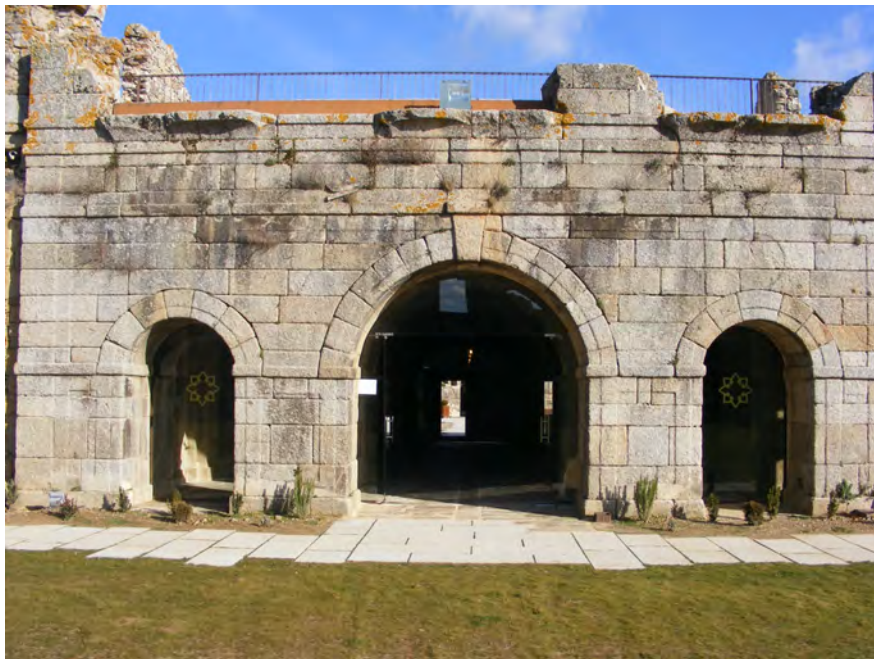
Figura 132. Fachada posterior del cuerpo de la portada principal del Fuerte de la Concepción de Aldea del Obispo.
