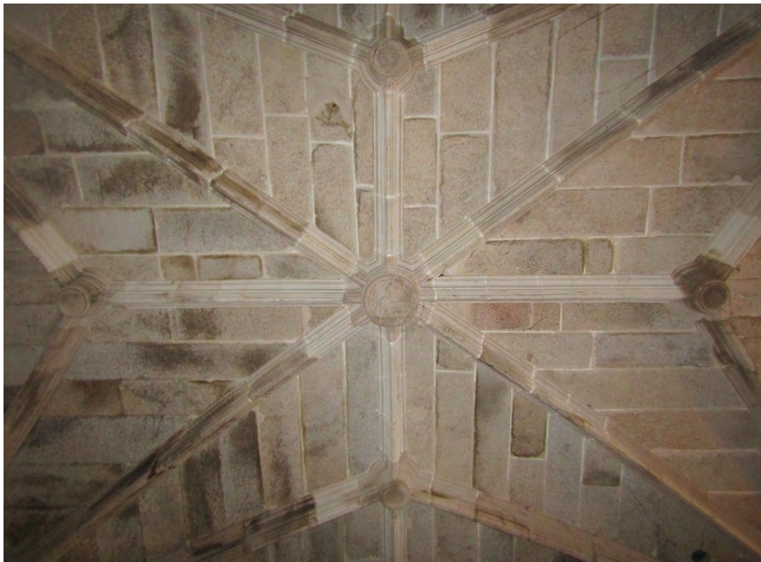
Figura 49. Detalle de la bóveda de cruceira del sotacoro de la iglesia de San Juan Bautista.
