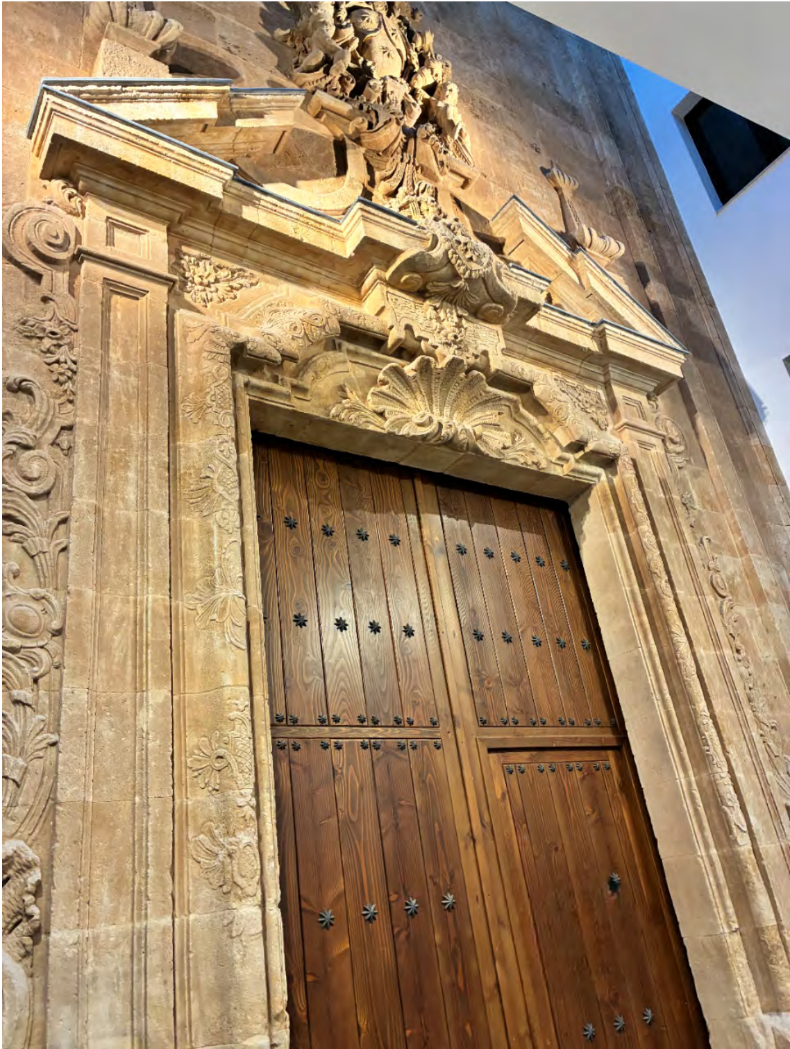
Figura. 90. Portada del lado de la Epístola de la iglesia del la Venerable Orden Tercera del Carmen.
