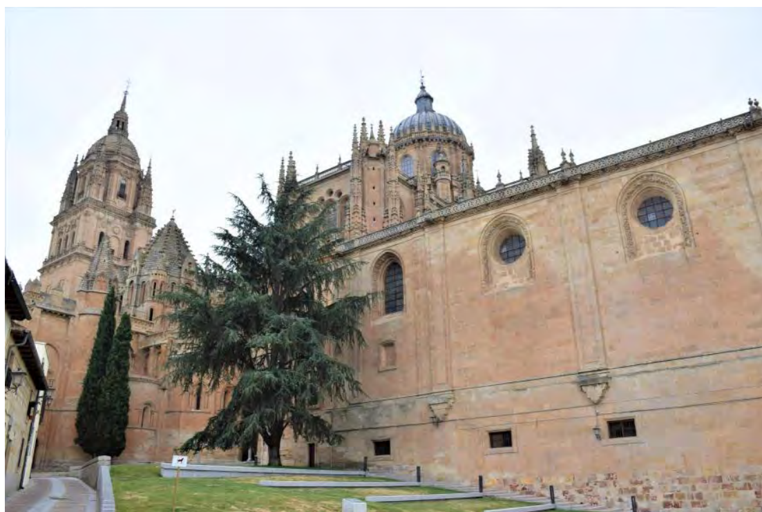
Figura. 19. Vista exterior de las sacristías de Prebendados y Capellanes.
