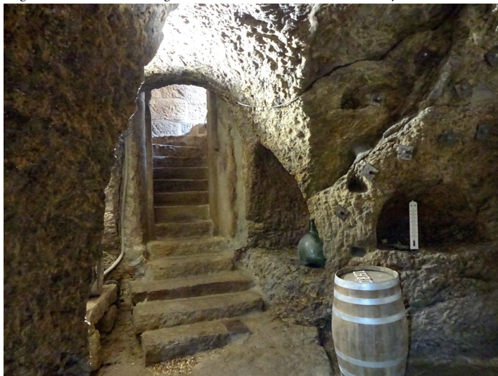
Figura 02. Fermoselle, bodega B01. Escalera de acceso, nave interior y nichos excavados
