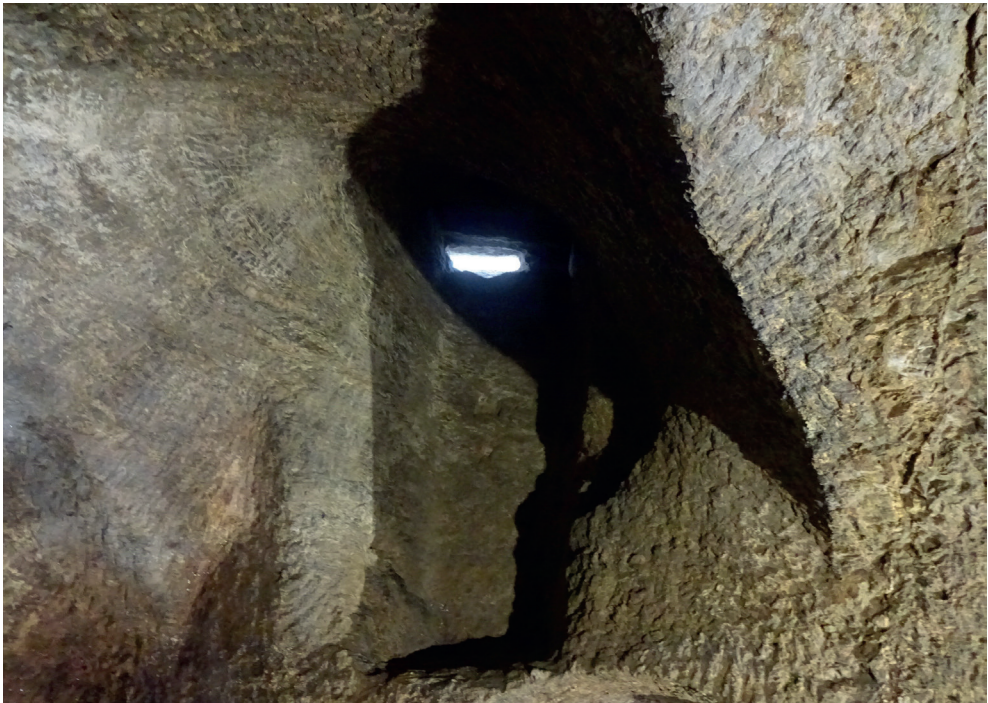
Figura 18. Fermoselle, bodega B01. Zarcera de ventilación que emerge desde la parte superior de la bóveda hasta la calle
