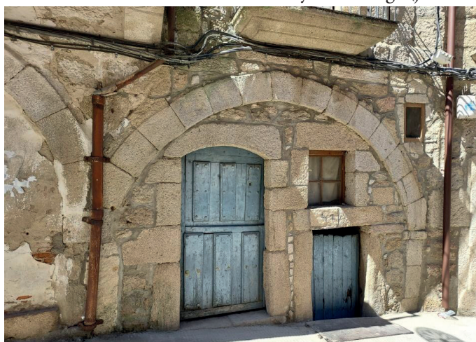
Figura 6. Caserío del casco histórico de Fermoselle, con una configuración relevante que mantiene doble acceso a la vivienda y a la bodega (julio 2022)
