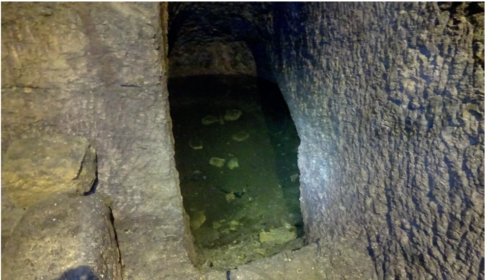
Figura 4. Fermoselle, bodega B08. Pozo de recogida de agua en el interior de la bodega
