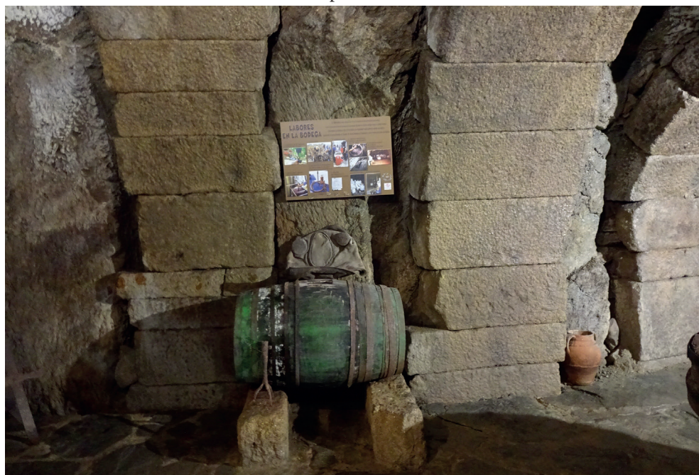
Figura 17. Fermoselle, bodega B04. Arcos de refuerzo ejecutados mediante sillares de piedra
