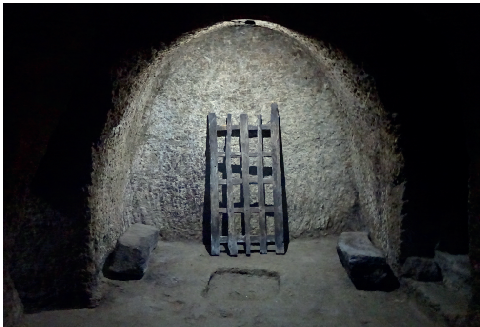
Figura 5. Fermoselle, bodega B03. Marcas y «picotadas» dejadas en el granito en el proceso de excavación de la bodega
