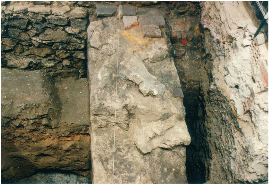
Ilustración 41. Antigua muralla al lado del río. Se puede observar el soporte de la pasarela.
