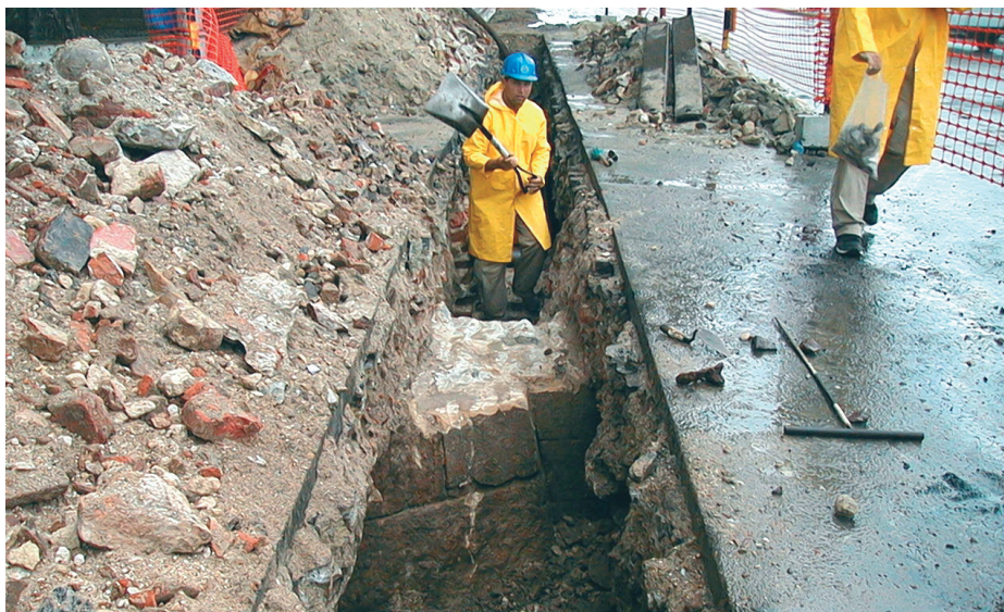
Ilustración 36. La zanja abierta para introducir los conductos fue cuidadosamente excavada para preservar las estructuras existentes. En primer plano, el aspecto del baluarte, en piedras labradas.
