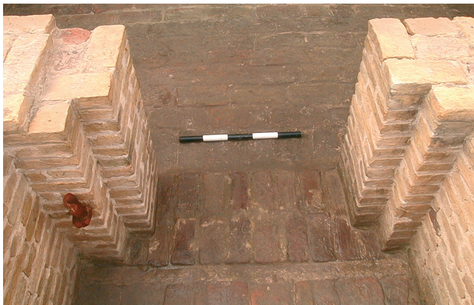
Ilustración 24. Detalle de la entrada del polvorín, construida con ladrillos «amarillentos» holandeses. Se observa parte de la bisagra que soportaba la puerta interior del polvorín, aún plomada en la pared.
