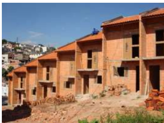
FIG.12–FOTO VALE DAS FLORES EM OBRAS. FONTE: ACERVO ASSESSORIA AMBIENTE 2018
