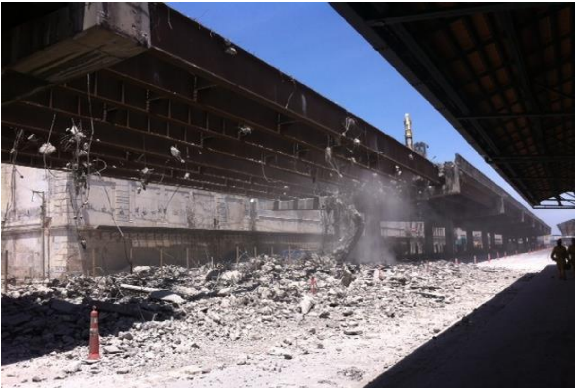
FIGURA 12 - DEMOLIÇÃO DO ELEVADO DA PERIMETRAL
