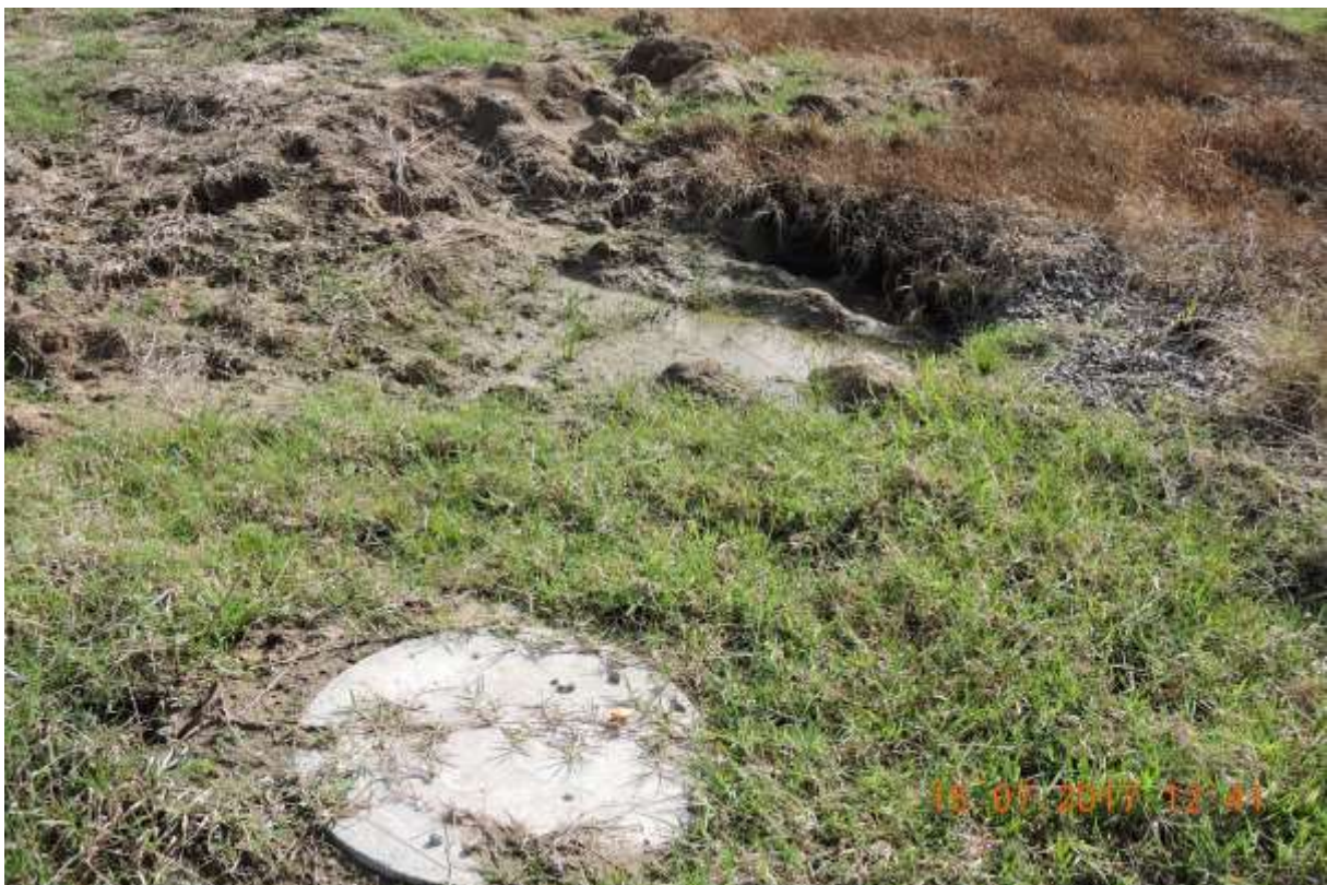
FIGURA 5: TRANSBORDAMENTO DO SISTEMA FOSSA-SUMIDOURO
