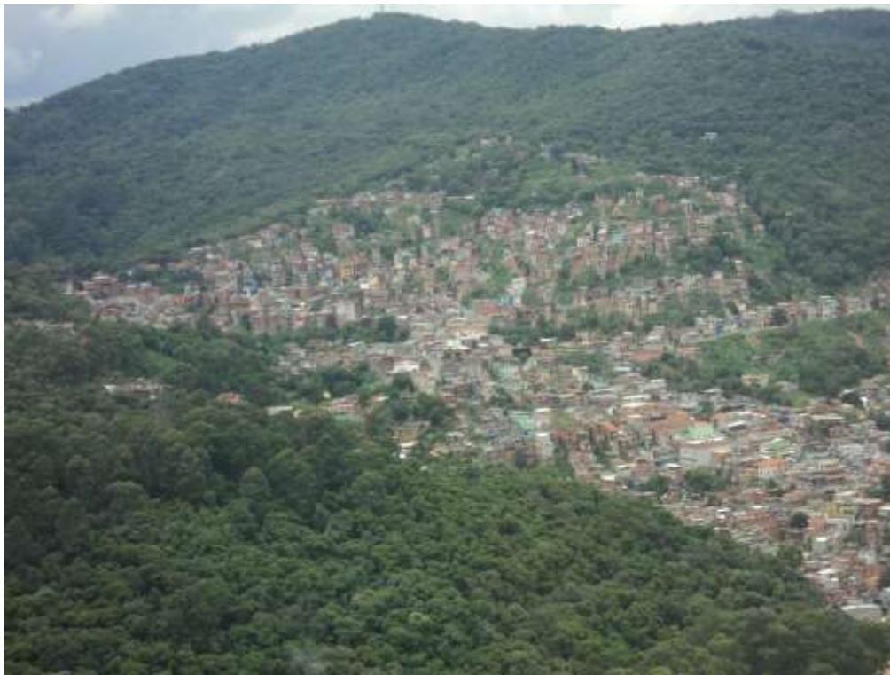
FOTO 01: OCUPAÇÃO IRREGULAR NA SERRA DA CANTAREIRA, PIRITUBA, ZONA NORTE DE SÃO PAULO
