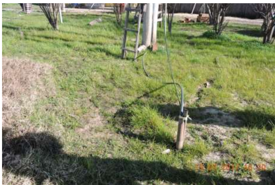
FOTO 4: POÇO TUBULAR SEM SELAMENTO DA INSTALAÇÃO
