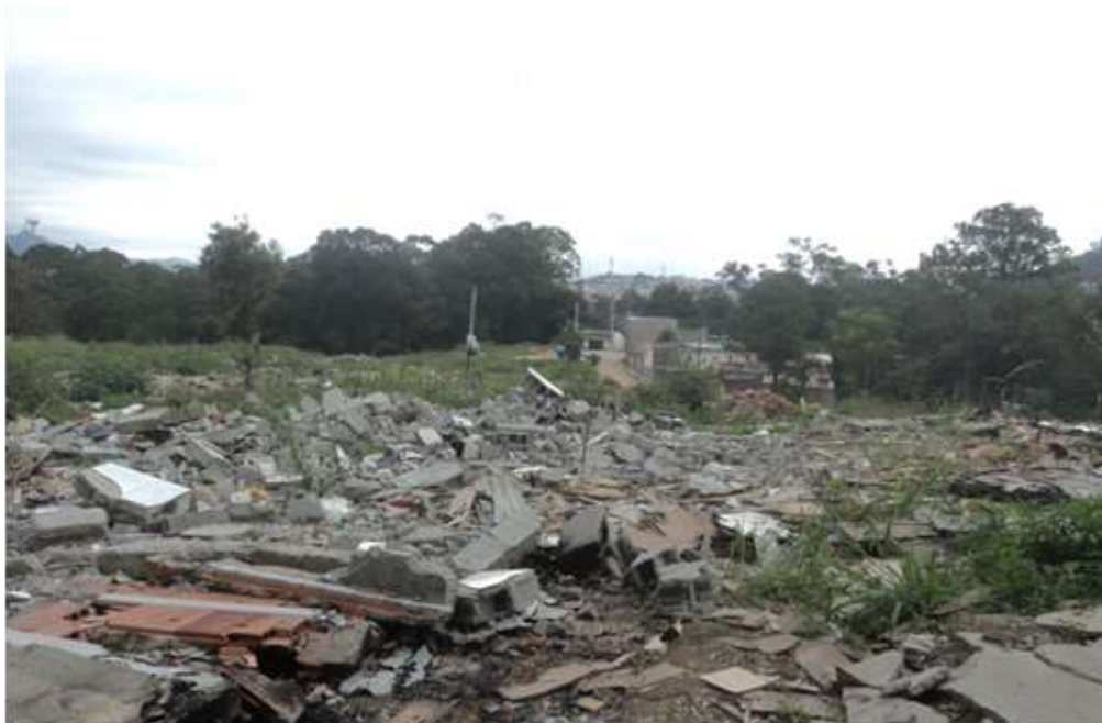
FOTO 04: VISTA PARCIAL DA ÁREA APÓS REINTEGRAÇÃO DE POSSE, PIRITUBA, SÃO PAULO
