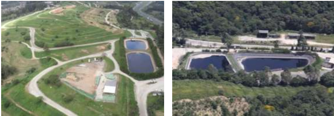
FIGURA 3: A DIREITA ATERRO BANDEIRANTES DESATIVADO. A ESQUERDA ATERRO DE SÃO JOÃO, AINDA ATIVO.
