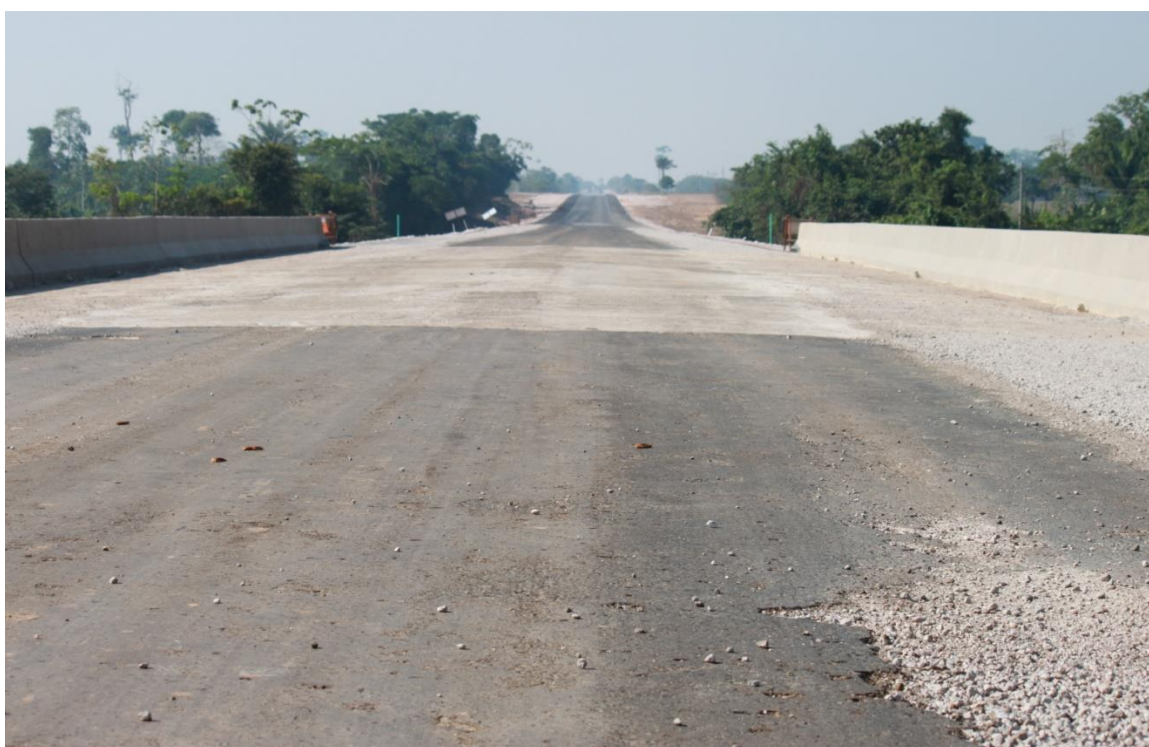
A nova ponte sobre o rio Almir... com extensão de 54 metros. PASSOS, 23/04/2016.
