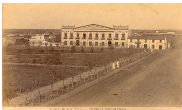
Casa Municipal de Esperanza- circa 1890 – Fotografía de Ernesto Schlie. Fuente: Museo de la Colonización. Esperanza.
