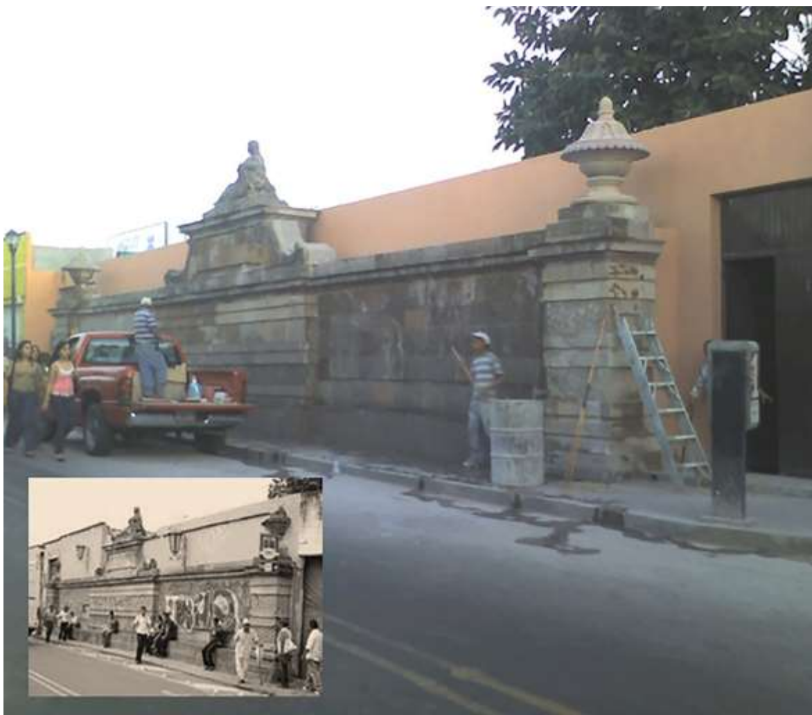
IMAGEN 3. EL PUENTE DE LAS MONAS, ANTES Y DESPUÉS DE SU RECUPERACIÓN
