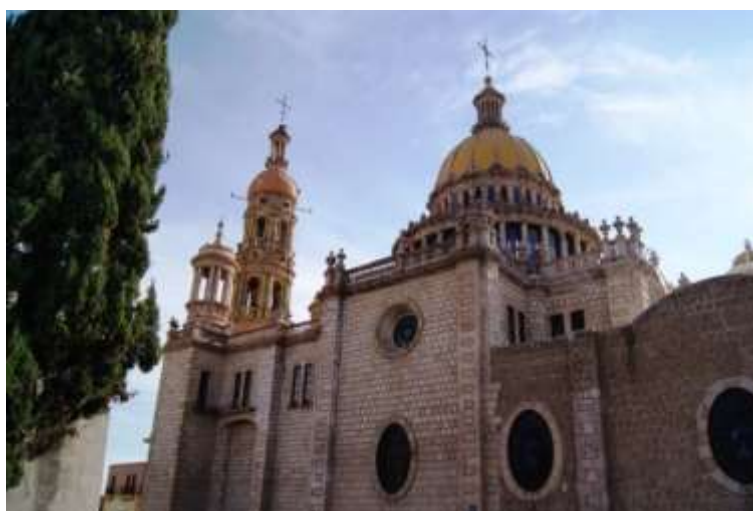
FIG. 6. VISTA POSTERIOR DEL TEMPLO DE SAN DIEGO CONCLUIDO EN 1908. EL EDIFICIO POSEE SISTEMAS CONSTRUCTIVOS DERIVADOS DE LAS EXPERIENCIAS INDUSTRIALES DE LOS TALLERES DEL FERROCARRIL.
