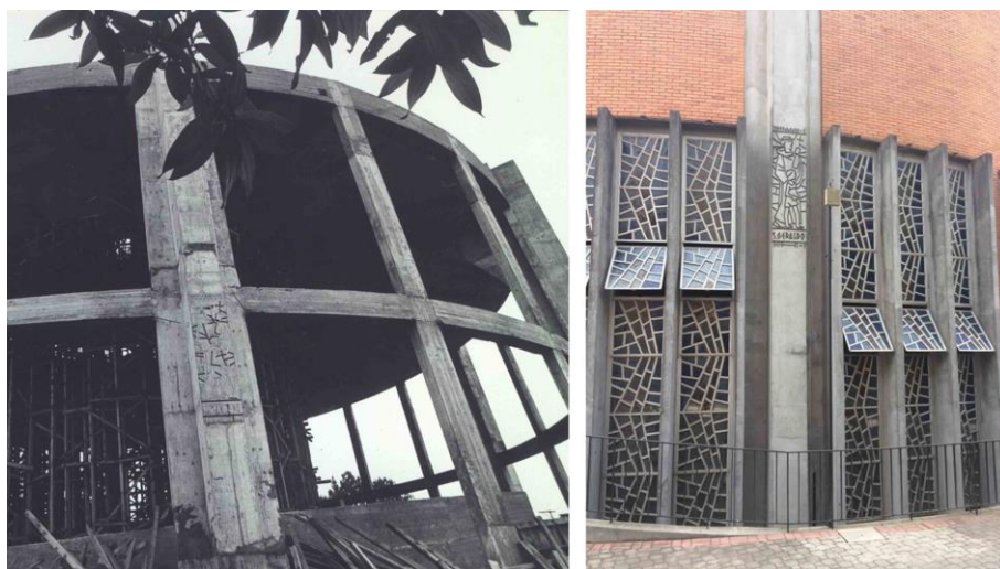
FIGURA 04 - MONTAJE DE IMÁGENES DEL DETALLE DE LA FACHADA - ACERVO CSA Y CHRISTIAN SEEGERER
