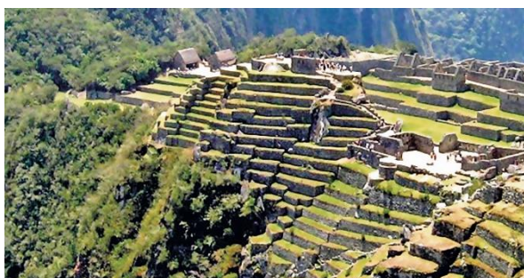
Machu Picchu. Izquierda : Andenes agrícolas y de contención anti deslizamientos en ladera oeste. Derecha : Gráfico que muestra en corte las capas de material de relleno para nivelar plazas y terrazas (Natgeotv.com)
