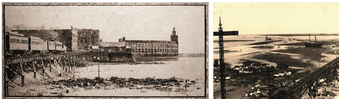
IZQ. FIG. 17. FOTO DEL VIADUCTO BUENOS AIRES-ENSENADA
