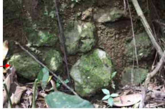
FIGURA 10 – DETALHE DAS PEDRAS DO ARRIMO – SÃO JULIÃO, MIGUEL BURNIER, OURO PRETO/MG
