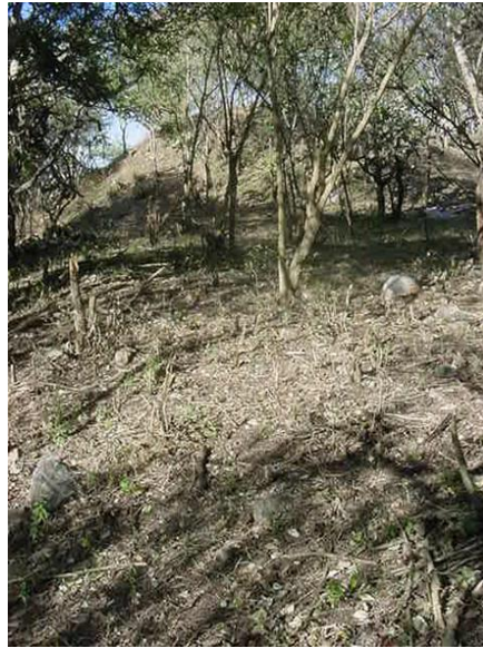
FIGURA 9. GRAN PLATAFORMA DE ACCESO, POR EL SUR, A LA ESTRUCTURA PRINCIPAL DEL CONJUNTO 2
