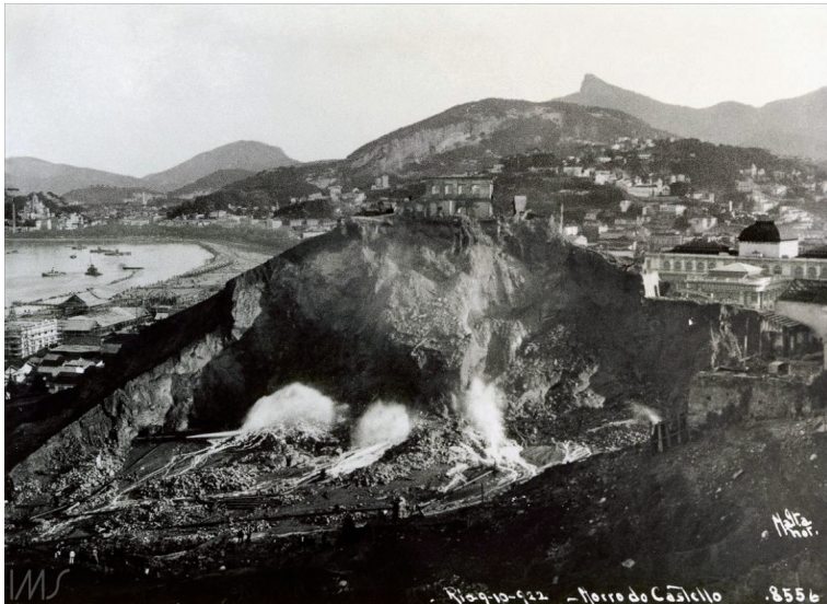
Imagem 1. Processo de desmonte do Morro do Castelo I.
