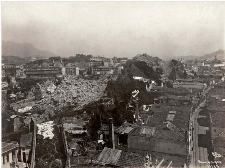
Imagem 2. Processo de desmonte do Morro do Castelo II.
