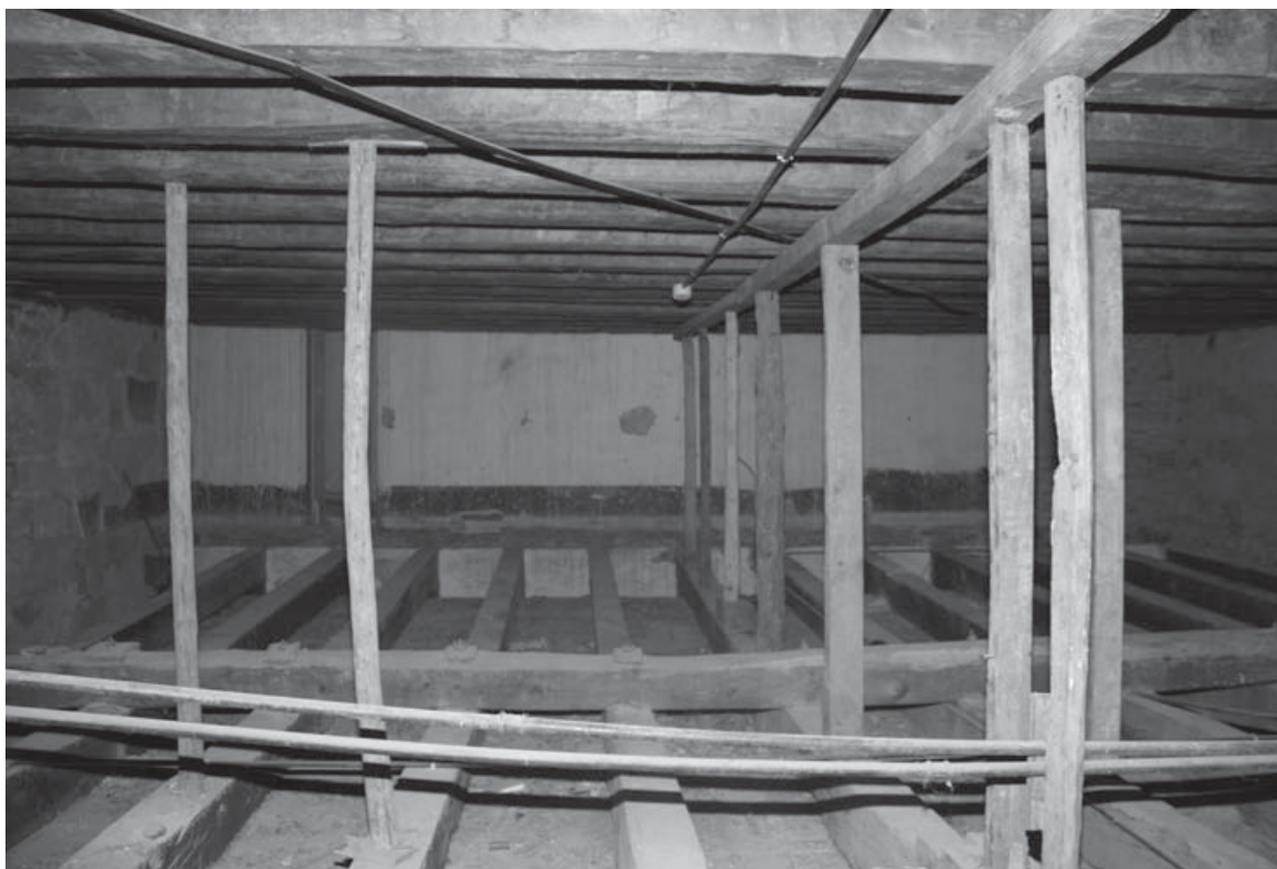
Fig. 7. Vigas de madera, hoy ocultas, de la techumbre que cubrió la actual Aula Alfonso X
