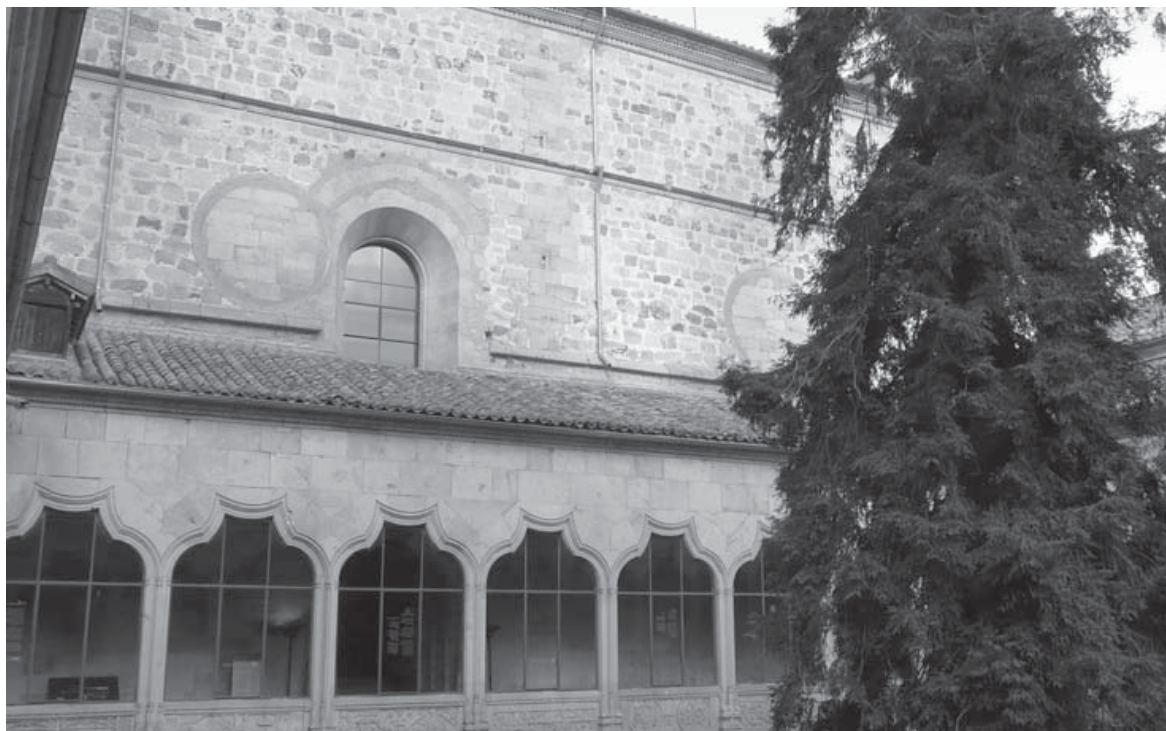
Fig. 2. Muro este de la Biblioteca, en el que se pueden observar los «espejos» o ventanas redondas y el caracol primitivos tapiados, además del recrecimiento del muro, rematado con molduras de motivos renacentes
