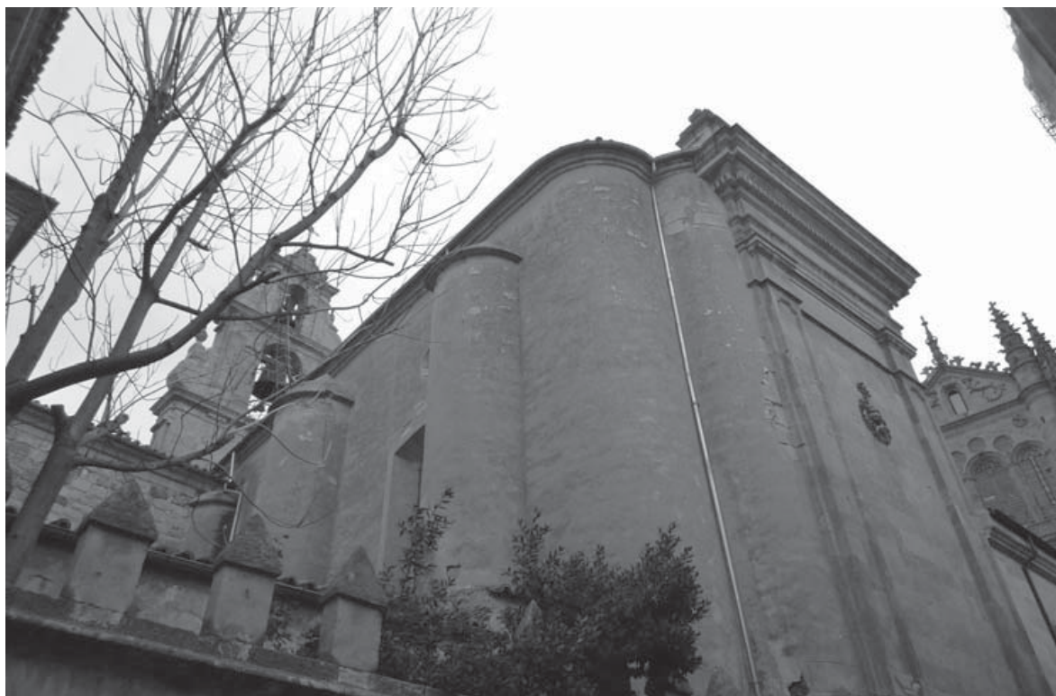
Fig. 7. Exterior de la capilla y biblioteca. Detalle de los contrafuertes
