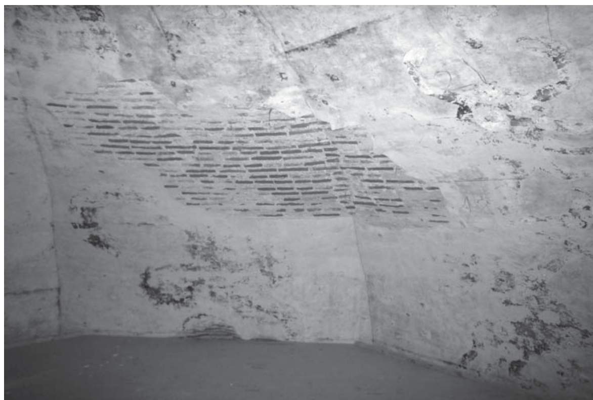
Fig. 8. Detalle del ochavo de la cubierta de la biblioteca
