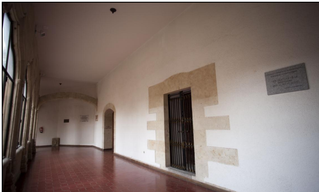
Galería sur del claustro alto donde se encontraba el pequeño corredor, con las actuales puertas del coro y de la sala de claustros
