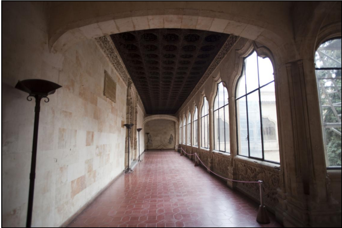
Galería oeste del claustro alto con la puerta de acceso a la librería en el lado izquierdo
