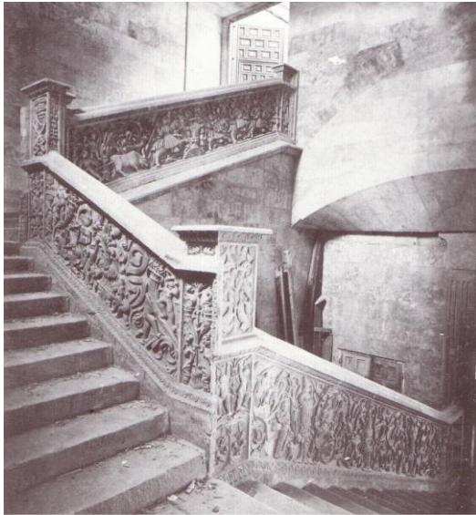
Foto de la escalera en la que se aprecia, en la parte derecha, una reja hoy desaparecida. Jean Laurent, 1840
