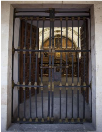
Puerta actual de acceso al coro, en el claustro alto
