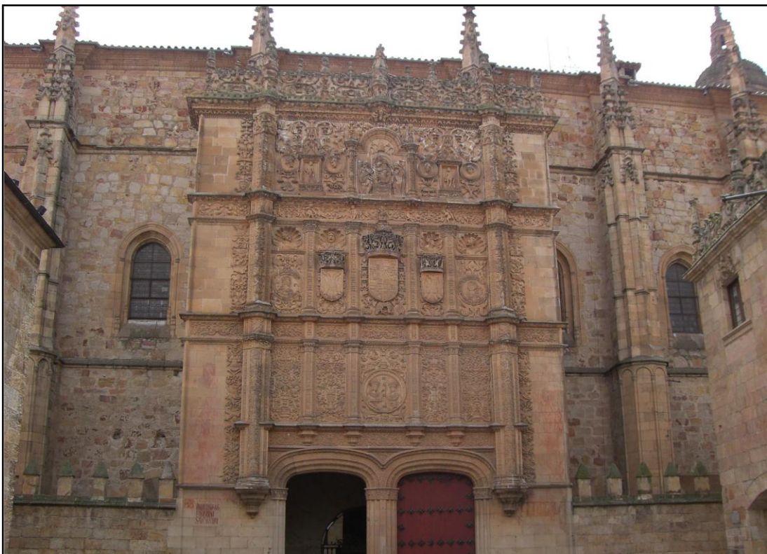
Portada principal de las Escuelas Mayores y almenas de la parte baja
