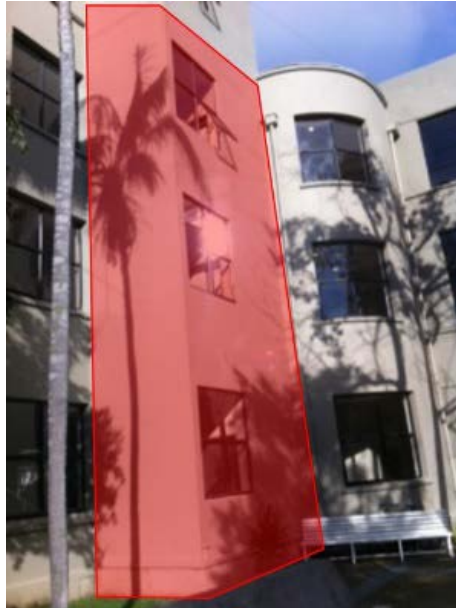
Foto 4. Fotografía incorporación ascensor Facultad Cs. Químicas 2004, elaboración propia.
