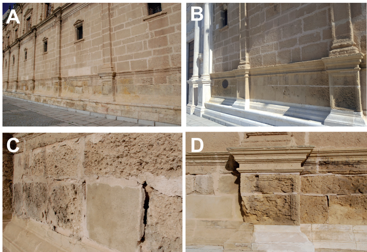
Figura 2. Observación visual de distintas zonas de las fachadas exteriores. A y B visiones generales, C y D detalles de las alteraciones presentes en piedra del Puerto. Fotografías de Jesús Espinosa Gaitán.
