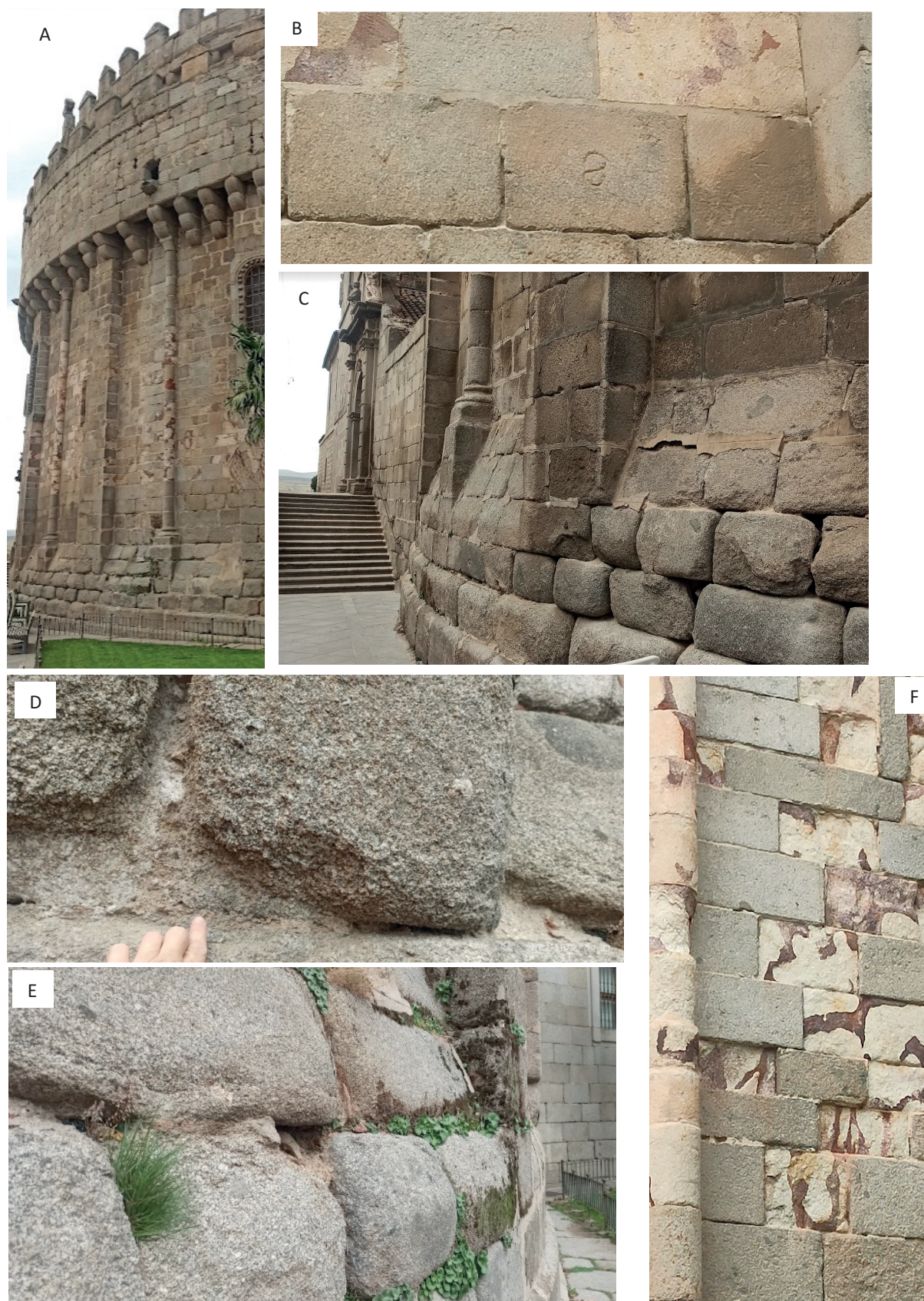
Figura 1. Localización del Granito Gris Avila (GGA), y de la Piedra Sangrante (PSR, PSB) en la Catedral de Ávila. A) Cimorro. B) Ensuciamiento y marcas de cantería en el GGA. C) Desplacación en el GGA. D) Detalle de C). E) Biodeterioro y desagregación en el GGA. F) Desplacación y pérdida de material en la PSR y PSB.
