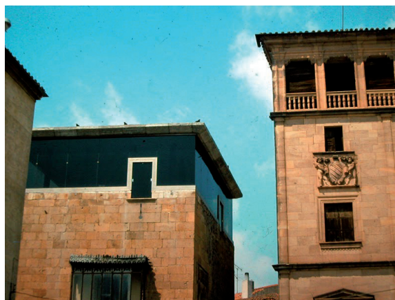
Figura 7. Torreón de Los Anaya o Torre de Abrantes con la intervención de Fernando Pulín en 1972
