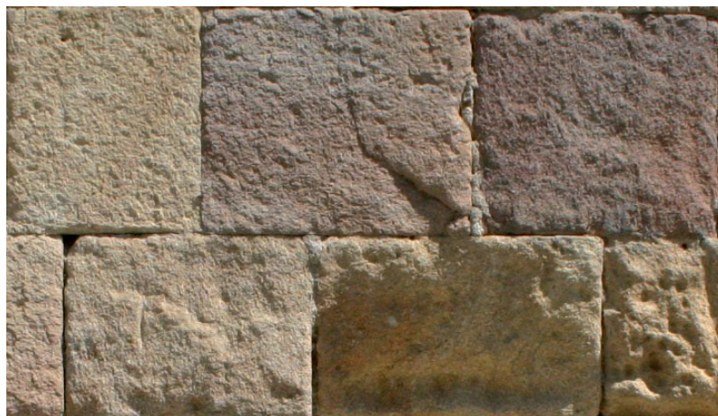
Figura 23. Muestra de deterioro de la piedra de la Colilla en la Iglesia de San Andrés de Ávila
