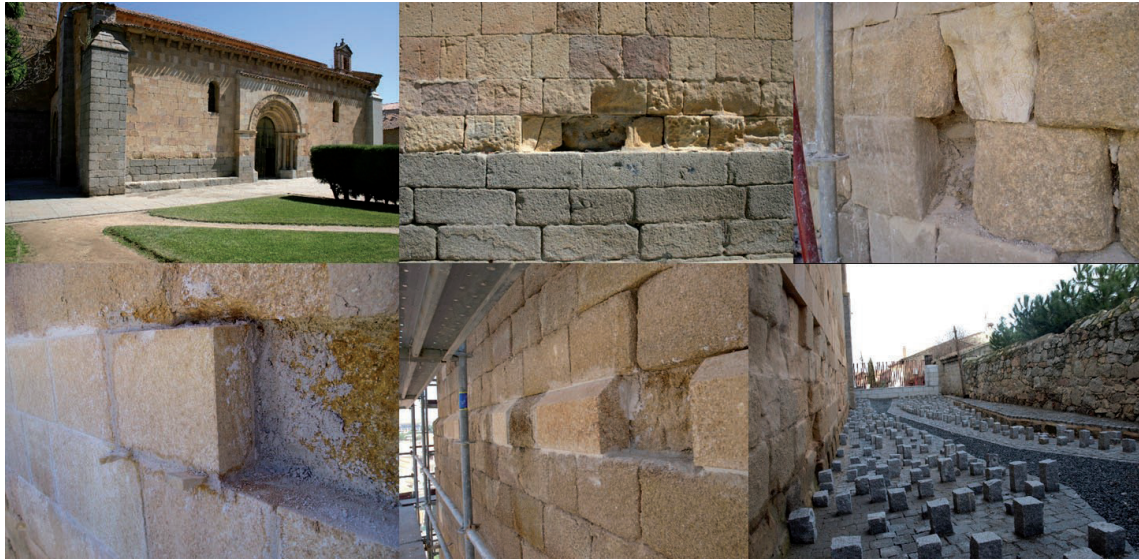
Figura 38. Reposiciones de sillares en la iglesia de San Andrés de Ávila
