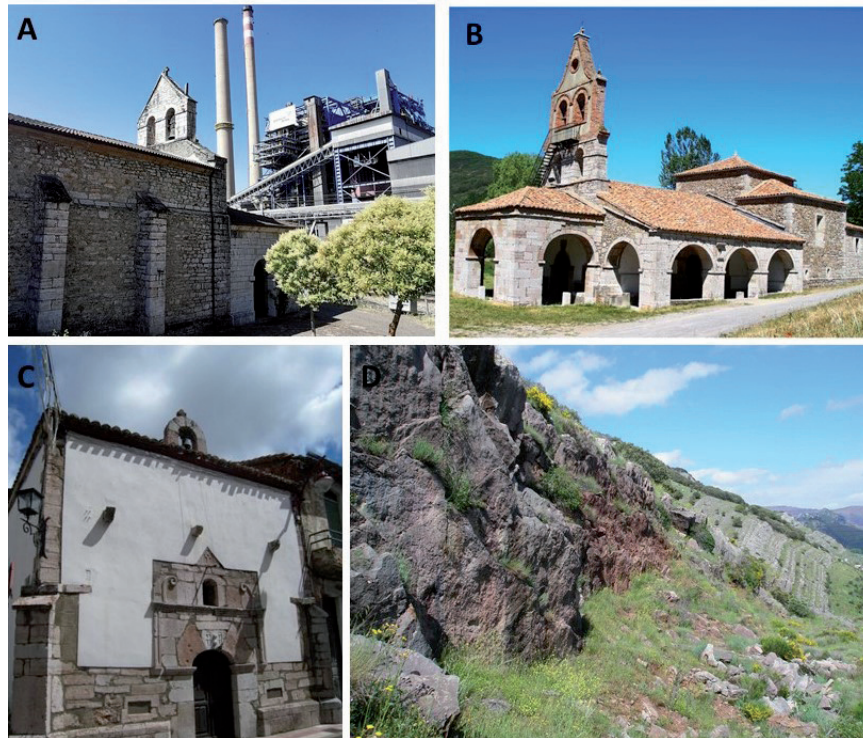
Figura 6. Elementos patrimoniales en la montaña leonesa en la segunda etapa del Camino del Salvador: La Robla-Buiza. A) Capilla de Nuestra Señora de Celada construida mayoritariamente con calizas procedentes de los afloramientos del Devónico, en particular de la Formación Santa Lucía; B) Santuario de la Virgen del Buen Suceso construido en buena sillería de calizas devónicas de la Formación Santa Lucía y carboníferas, facies Griotte. C) Capilla de San Antonio en La Pola de Gordón, empleo de calizas rojas facies Griotte y calizas devónicas. D) Cantera en las proximidades de la localidad de Vega de Gordón, frente de explotación de calizas rojas y grises bioclásticas de la Formación Santa Lucía (Devónico). Fotografías de Enrique Álvarez Areces.
