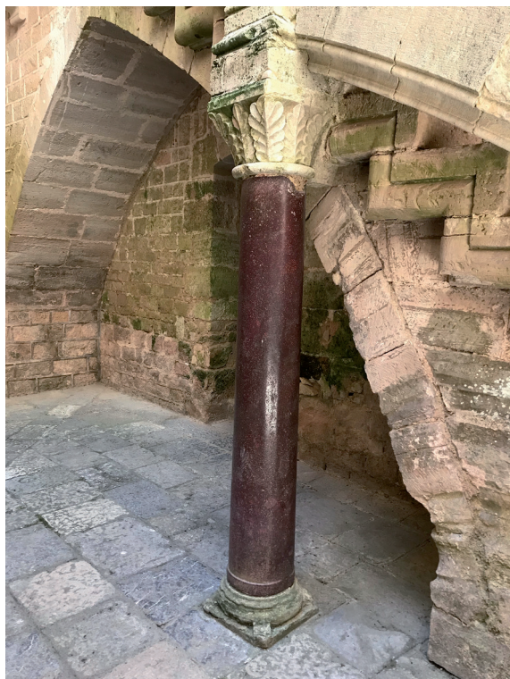
Figura 3. Columna de pórfido colocada en el palacio abacial del monasterio de Santes Creus. Fotografía de la autora.
