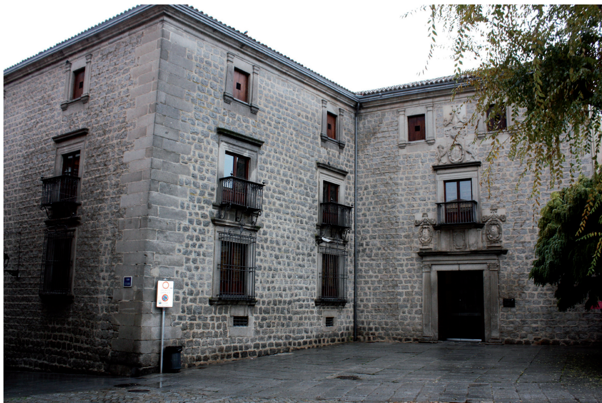
Figura 14. Palacio Los Serrano. Fotografía de E. Azofra.
