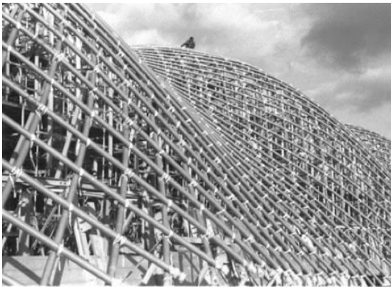
Fig. 223. Detalle estructura del Pabellón Japonés Expo Hannover 2000 hecha con tubos de cartón. Fuente: http://www.wikiarquitectura.com./building/japan-pavillion-expo-2000-hannover/
