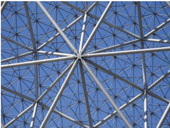
Fig. 121. Detalle de la malla hexagonal constitutiva de la geodésica “Biosfera” de Fuller. Fuente: https://www.plataformaarquitectura.cl/cl/758384/clasicos-de-arquitectura-biosfera-de-montreal-buckminster-fuller
