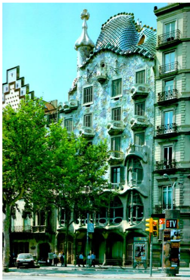
Fig. 156. Fachada principal de la casa Batlló. Fuente: ESTÉVEZ, A.T. Gaudí ... , p. 51.
