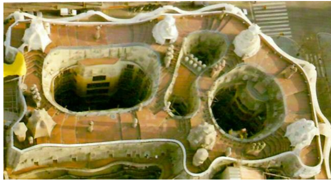
Fig. 160. Vista aérea de las terrazas de la casa Milá. Fuente: PERMANYER, L. y LEVICK, M. El Modernismo. Gaudí... , p. 150.
