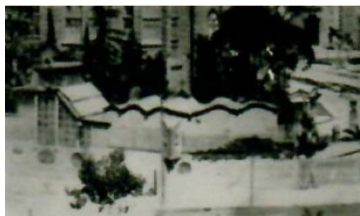
Fig. 168. Conoide de la cubierta del obrador de Gaudí. Fuente: GIRALT-MIRACLE, D. Gaudí. La búsqueda de la forma... , p. 90.
