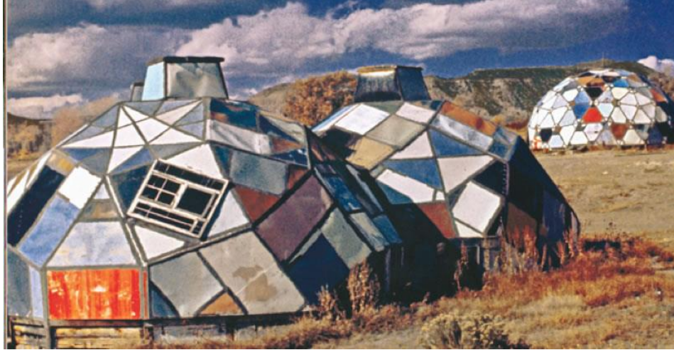
Fig. 122. Imagen primer plano de domos geodésicos de la “Drop city”. Fuente: http://www.sanatatak.com/view/drop-citynin-oykusu
