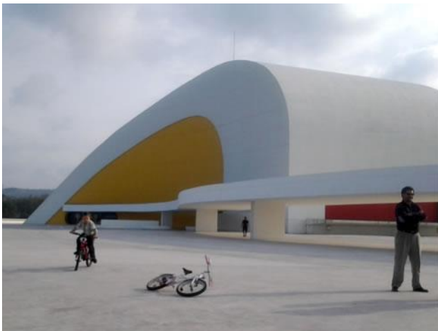
Fig. 179. Auditorio del Centro Cultural Internacional “Niemeyer”. Fotografía de Mercedes Torrens Bermejo.
