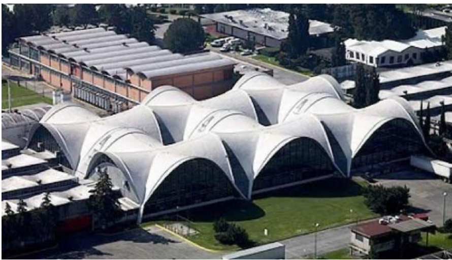
Fig. 202. Vista aérea del edificio de la embotelladora de Bacardí, en México. Fuente: https://www.disenoyarquitectura.net/2011/01/planta-de-embotellado-bacardi-de-felix
