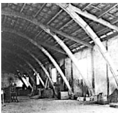
Fig. 182. Catenarias en la nave de la Cooperativa Mataronesa. Fuente: RAMÍREZ, J. A. La metáfora de la colmena... , p. 54.
