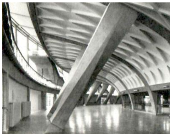
Fig. 106. Galería perimetral del Palacio de los deportes de Roma. Fuente: DESIDERI, P., NERVI, P. L. y POSITANO, G. Pier Luigi Nervi... , p. 100.
