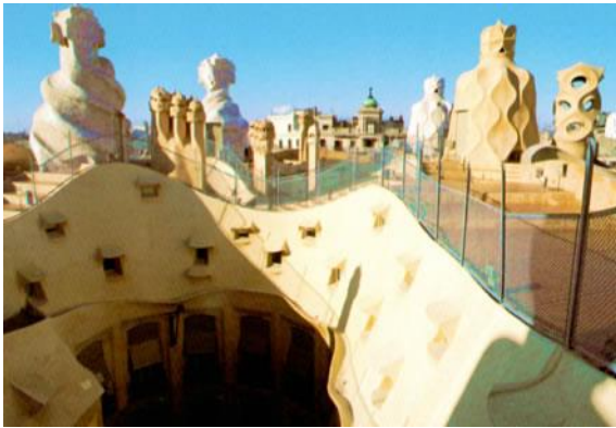
Fig. 161. Distintas tipologías de los remates de los conductos en el terrado funcionales y escultóricos. Fuente: PERMANYER, L. y LEVICK, M. El Modernismo. Gaudí... , p 161.
