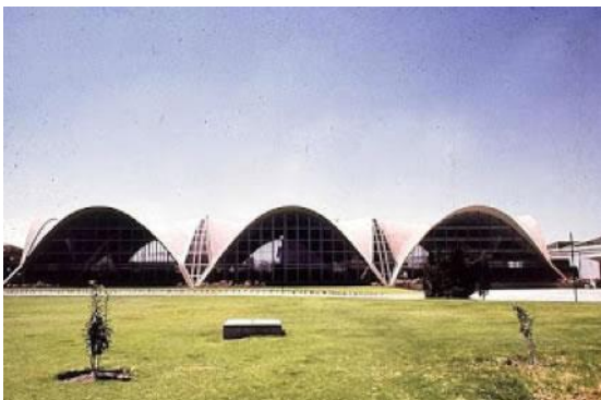
Fig. 203. Alzado del edificio de la embotelladora de Bacardí, en México. Fuente: https://www.disenoyarquitectura.net/2011/01/planta-de-embotellado-bacardi-de-felix
