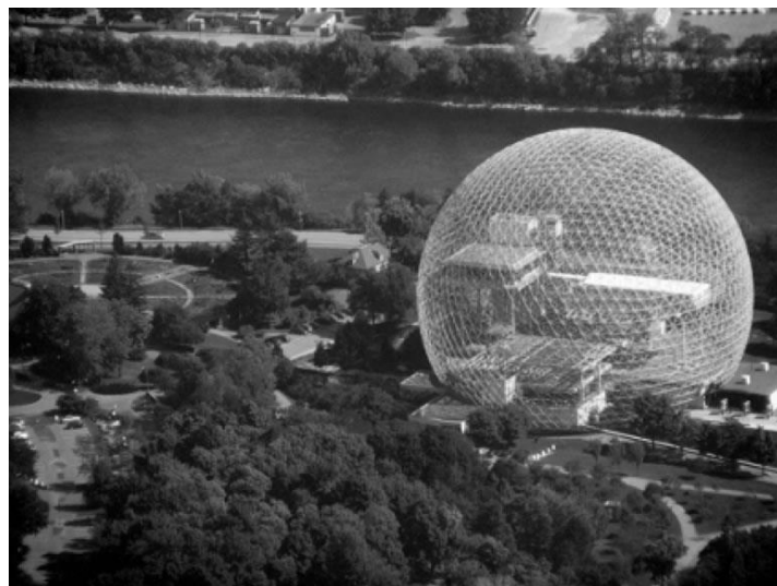
Fig. 120. Domo geodésico “Biosfera” de Fuller del pabellón de EEUU para la Exposición Mundial de 1967. Fuente: https://www.plataformaarquitectura.cl/cl/758384/clasicos-de-arquitectura-biosfera-de-montreal-buckminster-fuller
