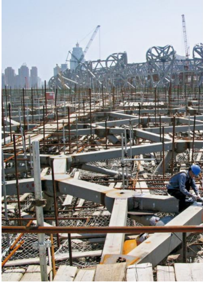
Fig. 133. Estructura iterativa llevada a cabo en la construcción del Centro Nacional de Natación de Pekín. Fuente: http://www.bubblemania.fr/es/architecture-re-bulle-cube-deau-2003-2008-pekin-chine/
