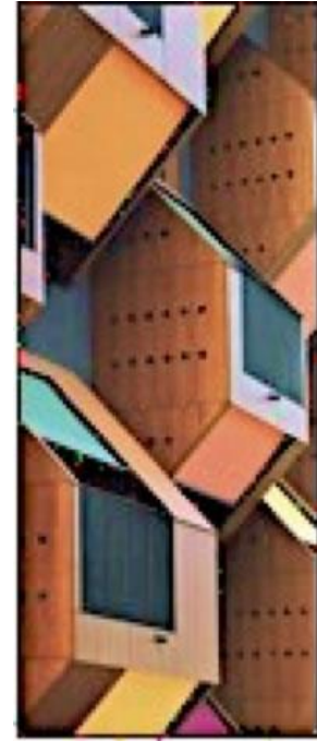
Fig. 127. Detalle de los apartamentos Izola. Fuente: BAHAMÓN, A. Analogías... , p. 131.
