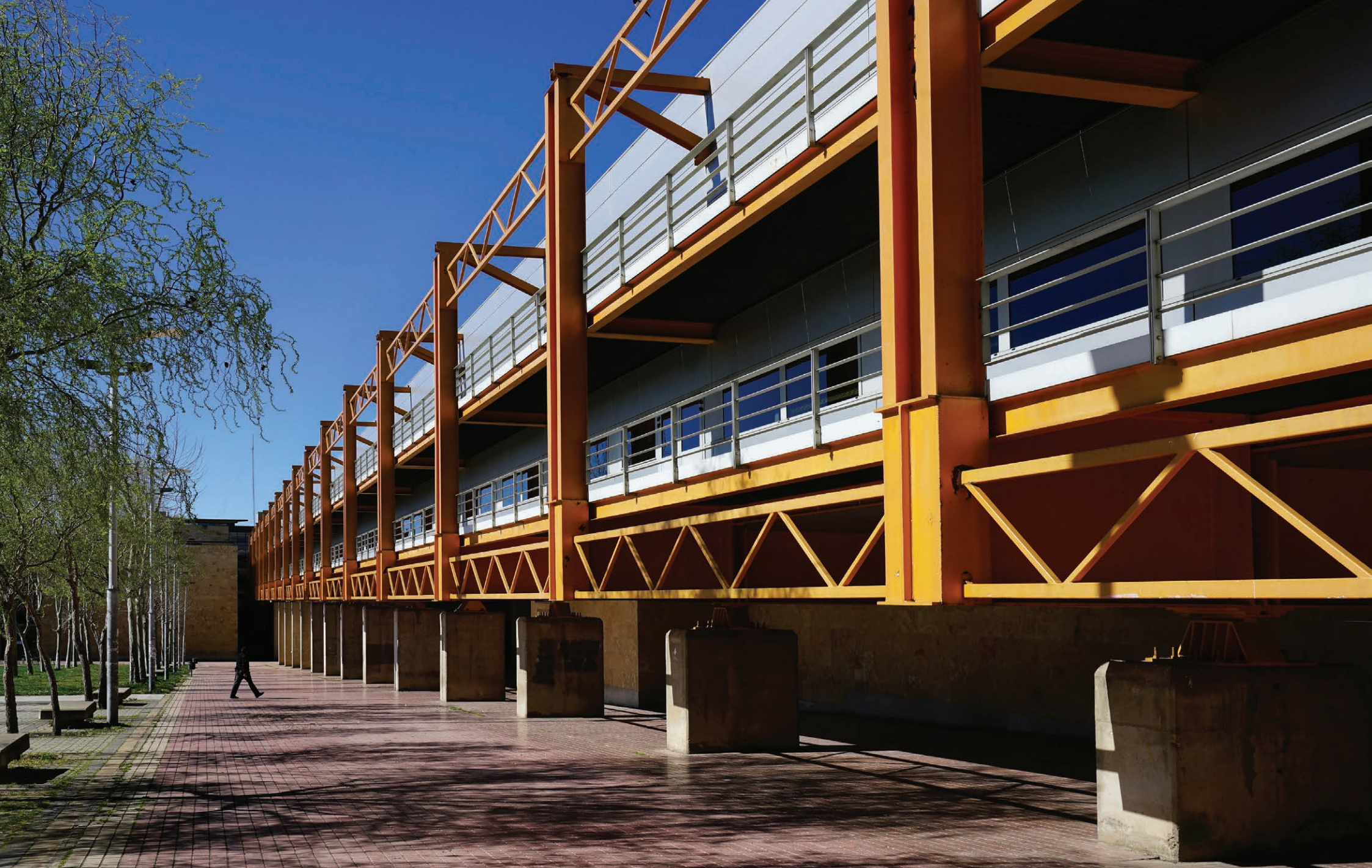
^ Tratamiento del frente abierto a la plaza de la Universidad de Bolonia, con estructura de estética maquinista, volada sobre pilares de hormigón.
