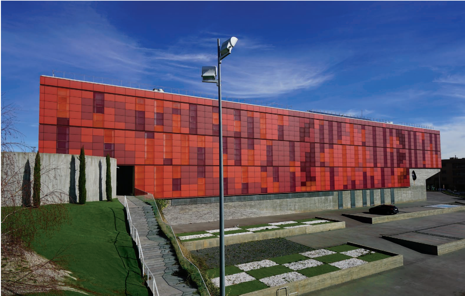
> Zona escalonada de aparcamiento y jardines, con el volumen curvo del salón de actos en hormigón a la izquierda.
