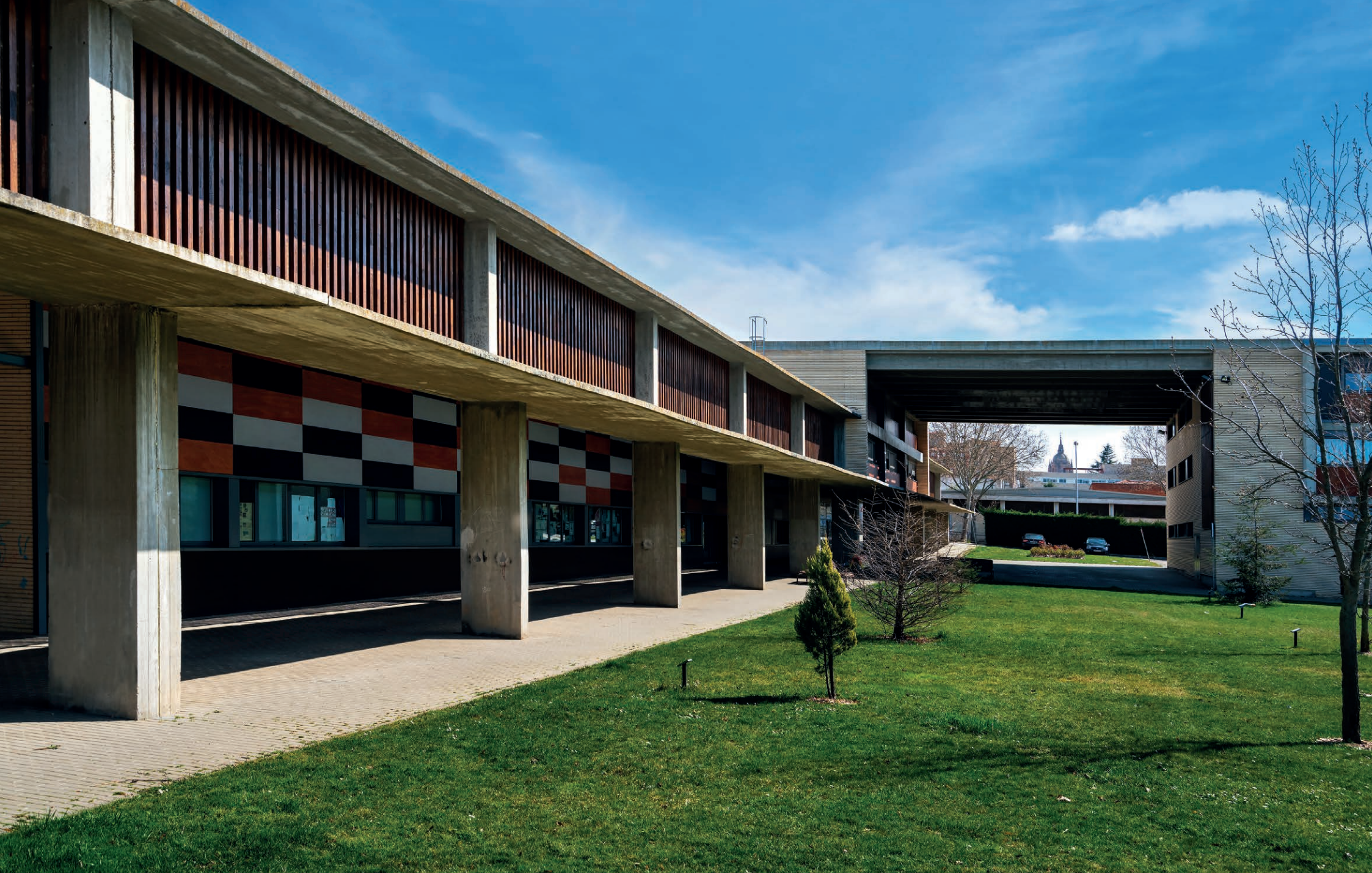
^ Pórtico orientado al sur, con pilares de hormigón visto y celosías sobre ellos que tamizan la luminosidad del interior.
