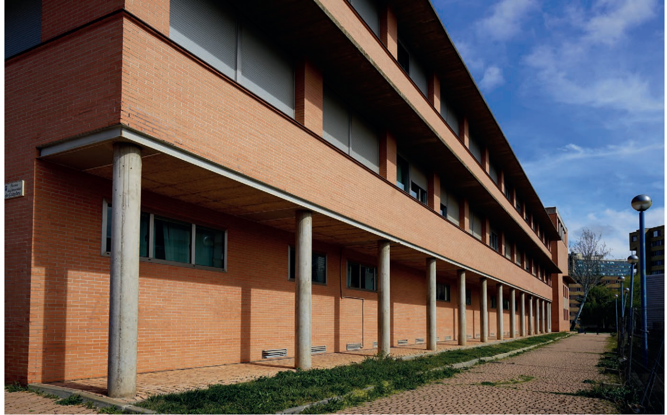
^ Detalle de la fachada oriental.
