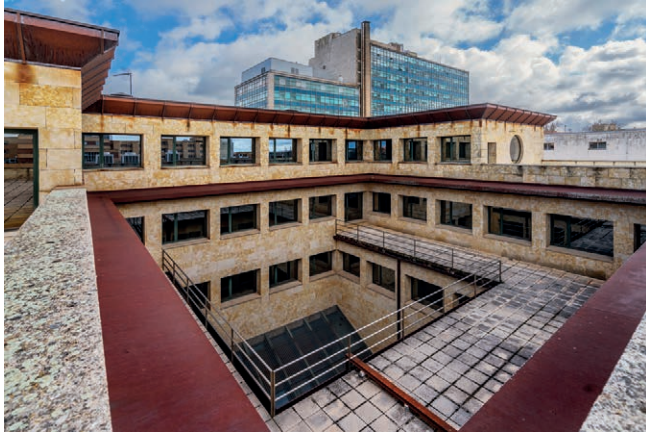
^ Un patio central perfora el edificio desde la primera planta para facilitar la iluminación.
