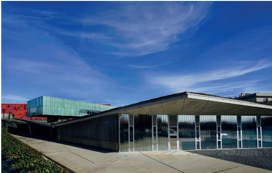
< Pórtico de acceso y área de laboratorios desarrollados bajo una plataforma de hormigón.
