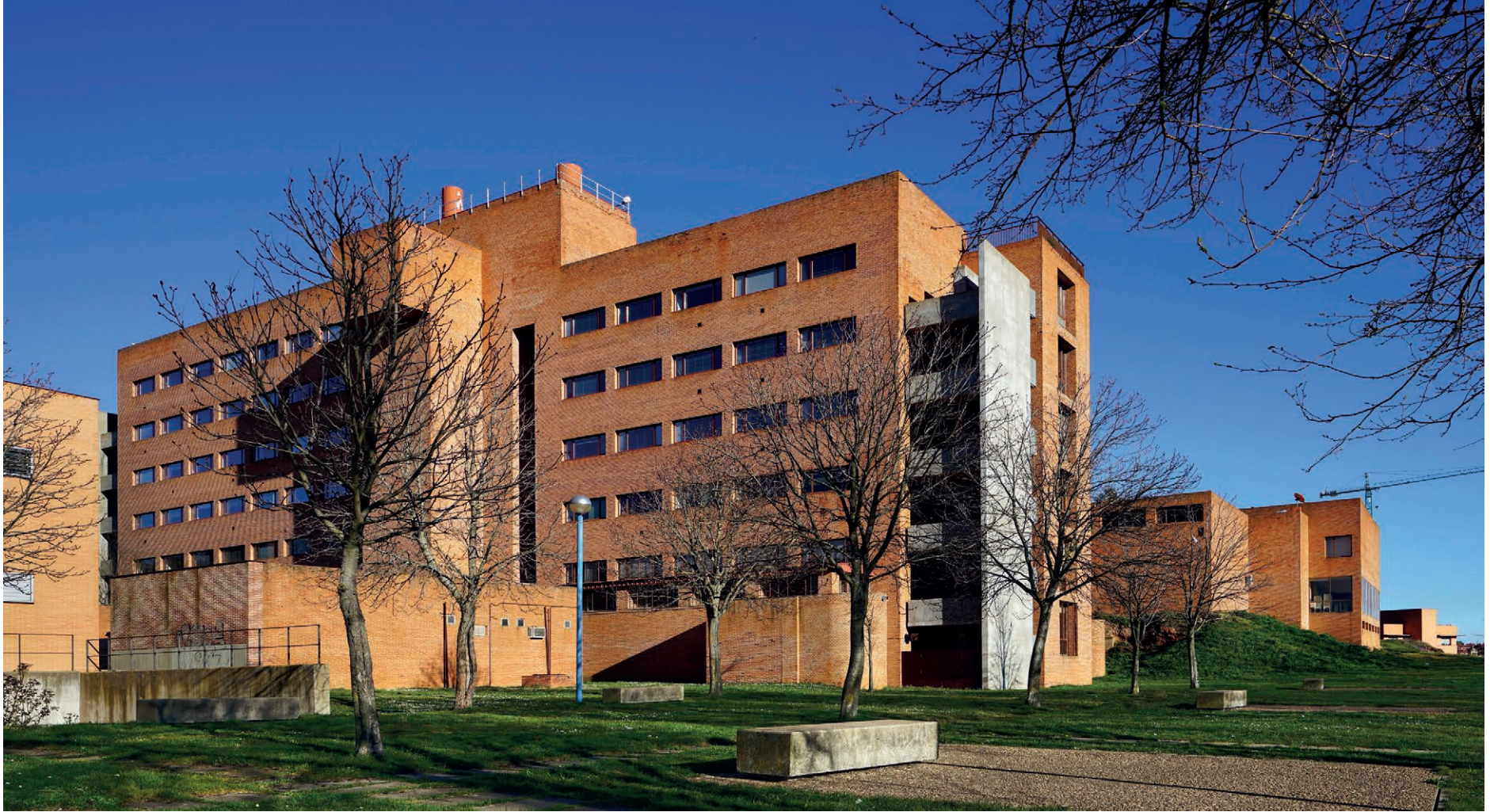
∨ Bloque departamental al oeste, desarrollado en altura.
