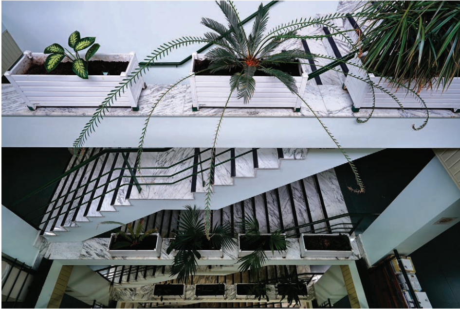
Escalera que parte del vestíbulo y comunica los cinco niveles del edificio.
