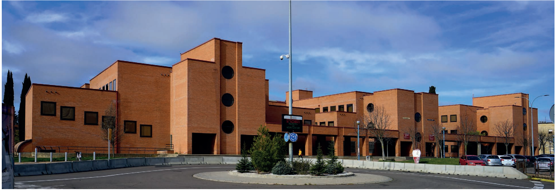
^ Vista general del edificio desde el norte.
