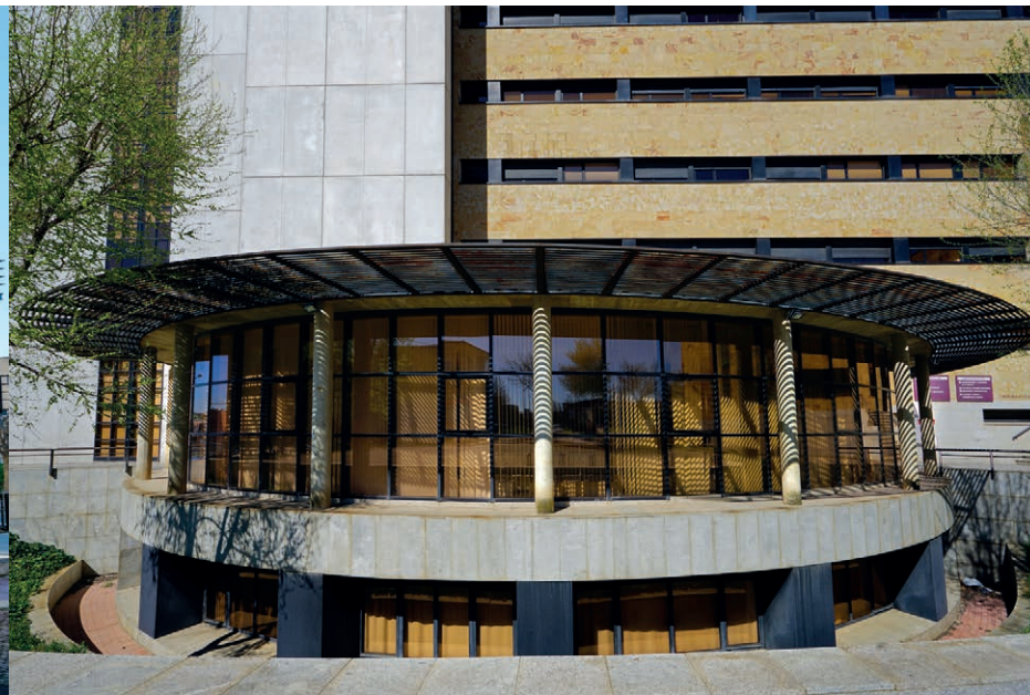
^ Pérgola curva en la entrada al área departamental.
