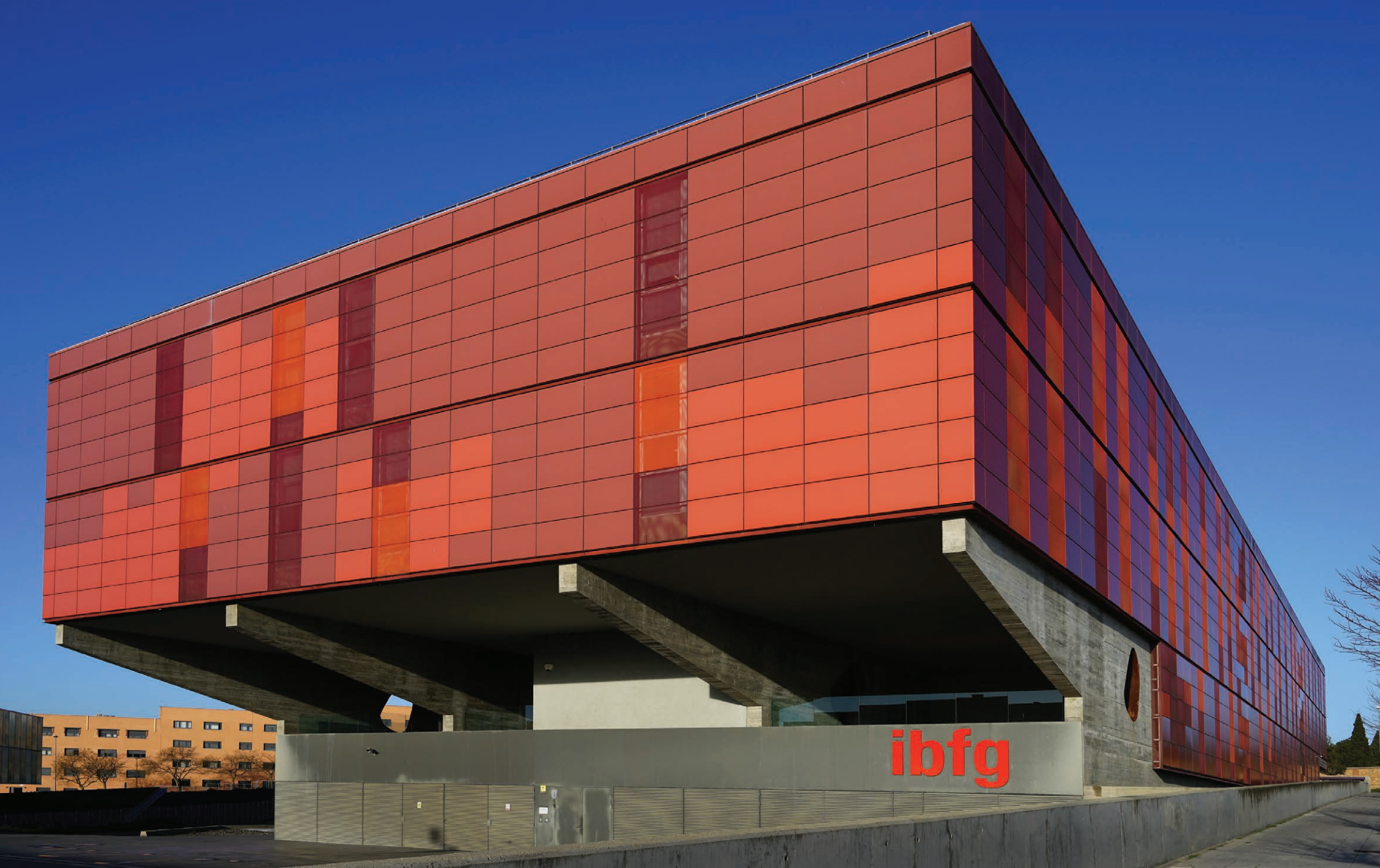
^ Entrada vehicular para carga y descarga bajo grandes ménsulas de hormigón.
