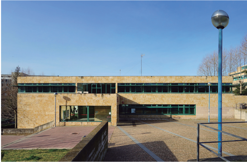
^ Fachada principal del Aulario.
