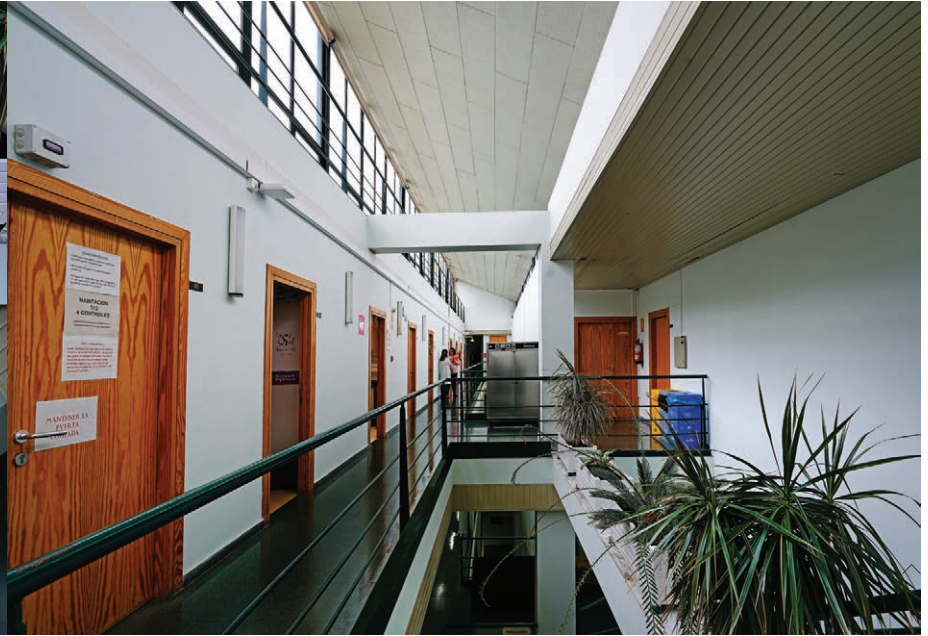
Galería superior desde donde se observan los puentes de comunicación entre las dos alas del edificio y el lucernario que proporciona iluminación cenital.
