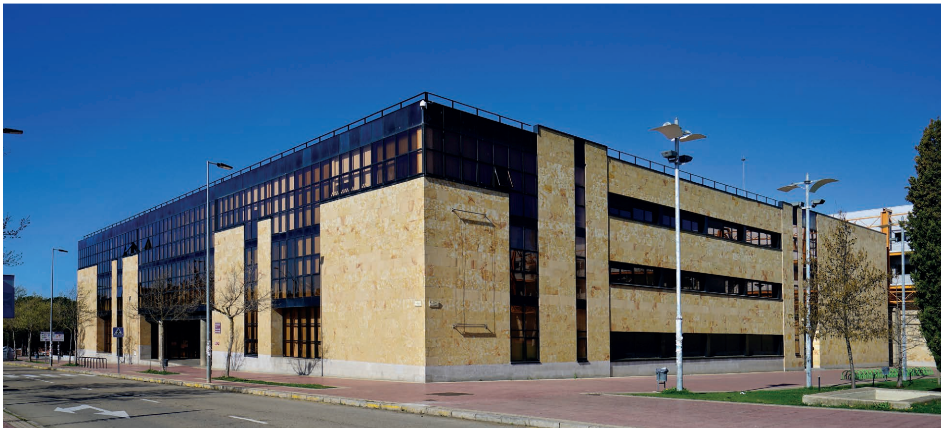
∨ Aulario del edificio FES.
