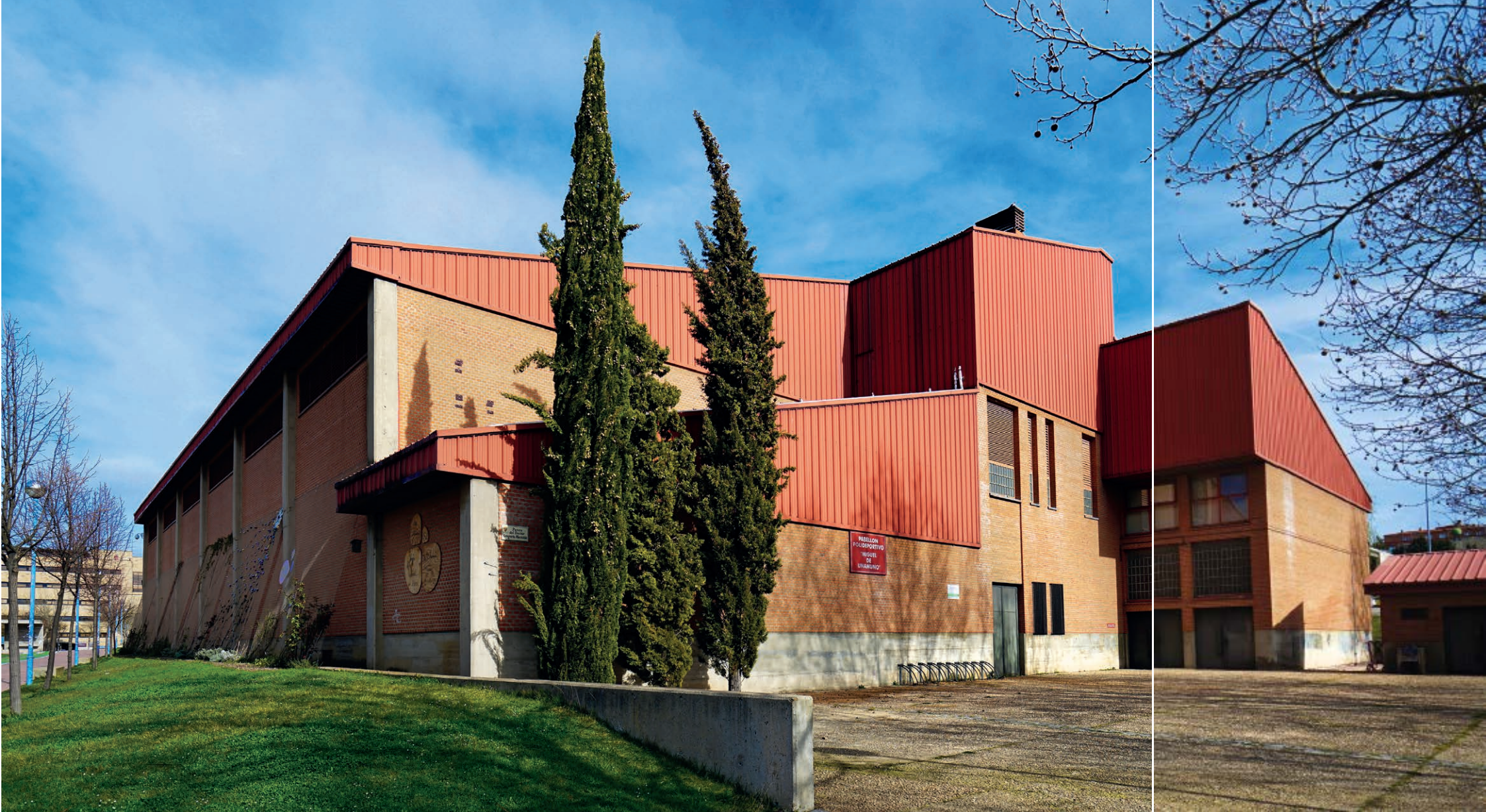
^ En el exterior se combina la estructura de hormigón visto de zócalos y pilares, con cerramiento en ladrillo para armonizar con los edificios colindantes, y cubiertas de planchas de acero.
