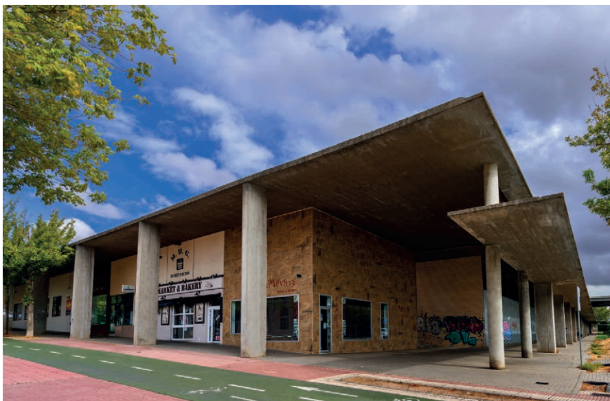
^ Ángulo de las galerías en forma de "L", que ocultan construcciones preexistentes en el campus.
