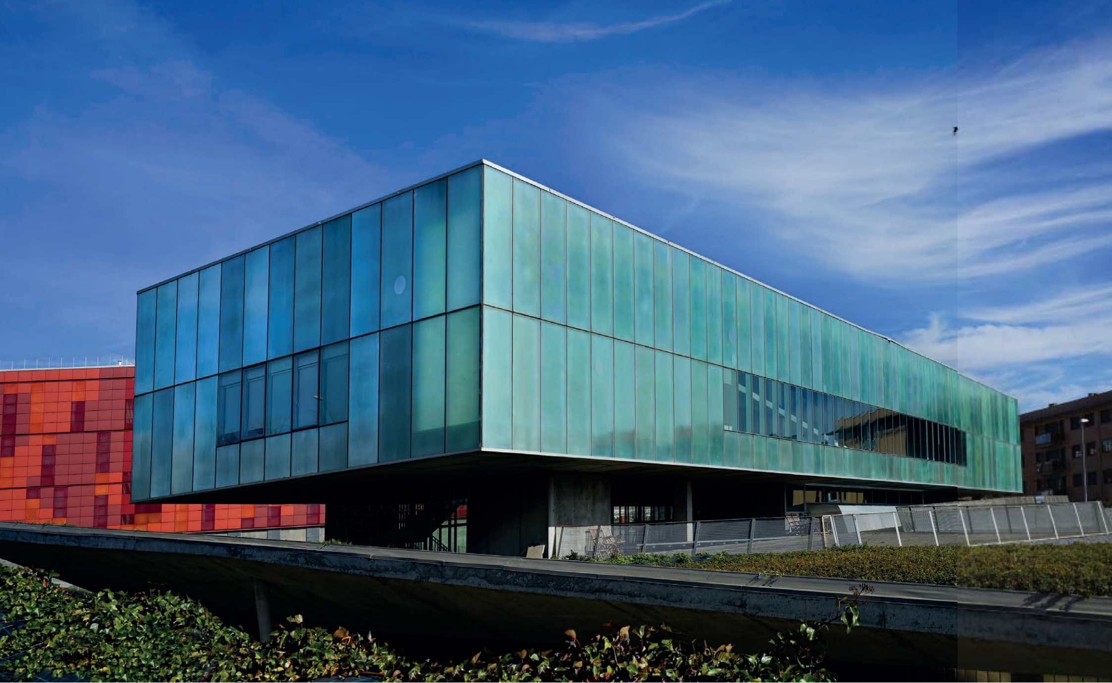
^ Prisma de líneas nítidas, que singulariza el inmueble, cerrado al exterior con vidrio estriado.
