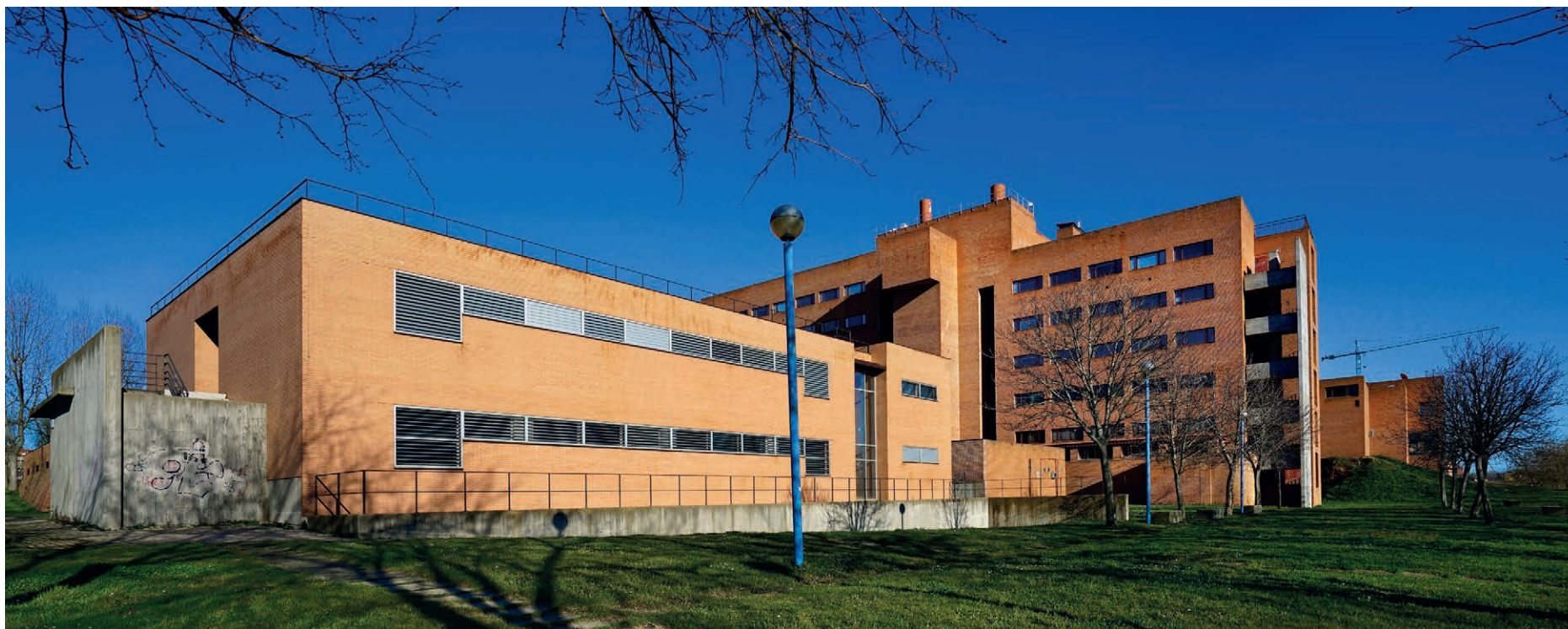
∨ Fachada sur junto al bloque departamental de Farmacia.
