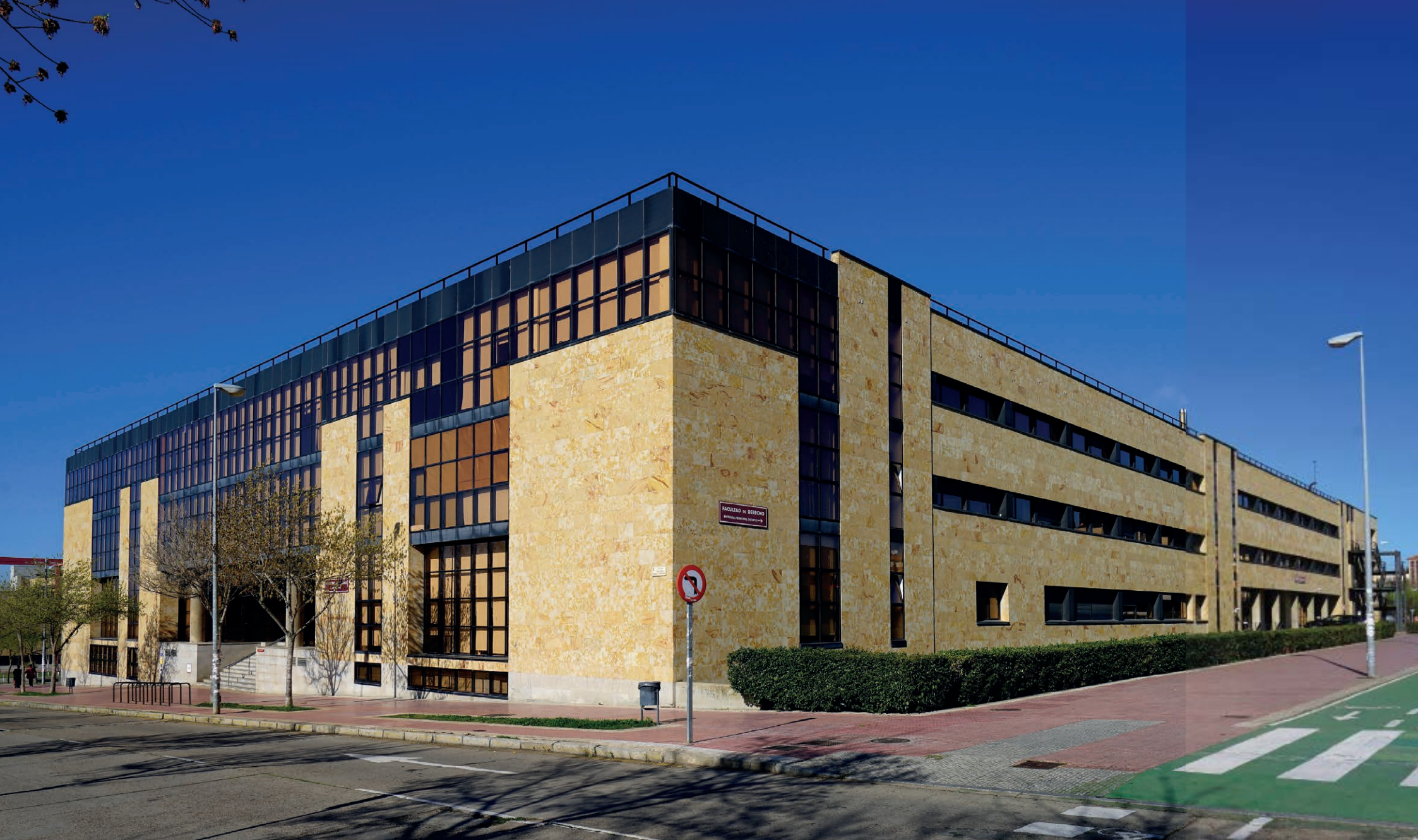
^ Esquina donde confluyen el lienzo de la fachada principal y el de la avenida de los Maristas, que cuenta con un acceso secundario.
