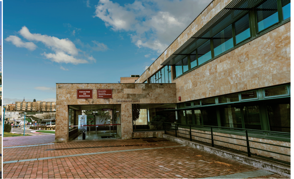
^ Vestibulo de entrada al Aulario, en la fachada principal.
