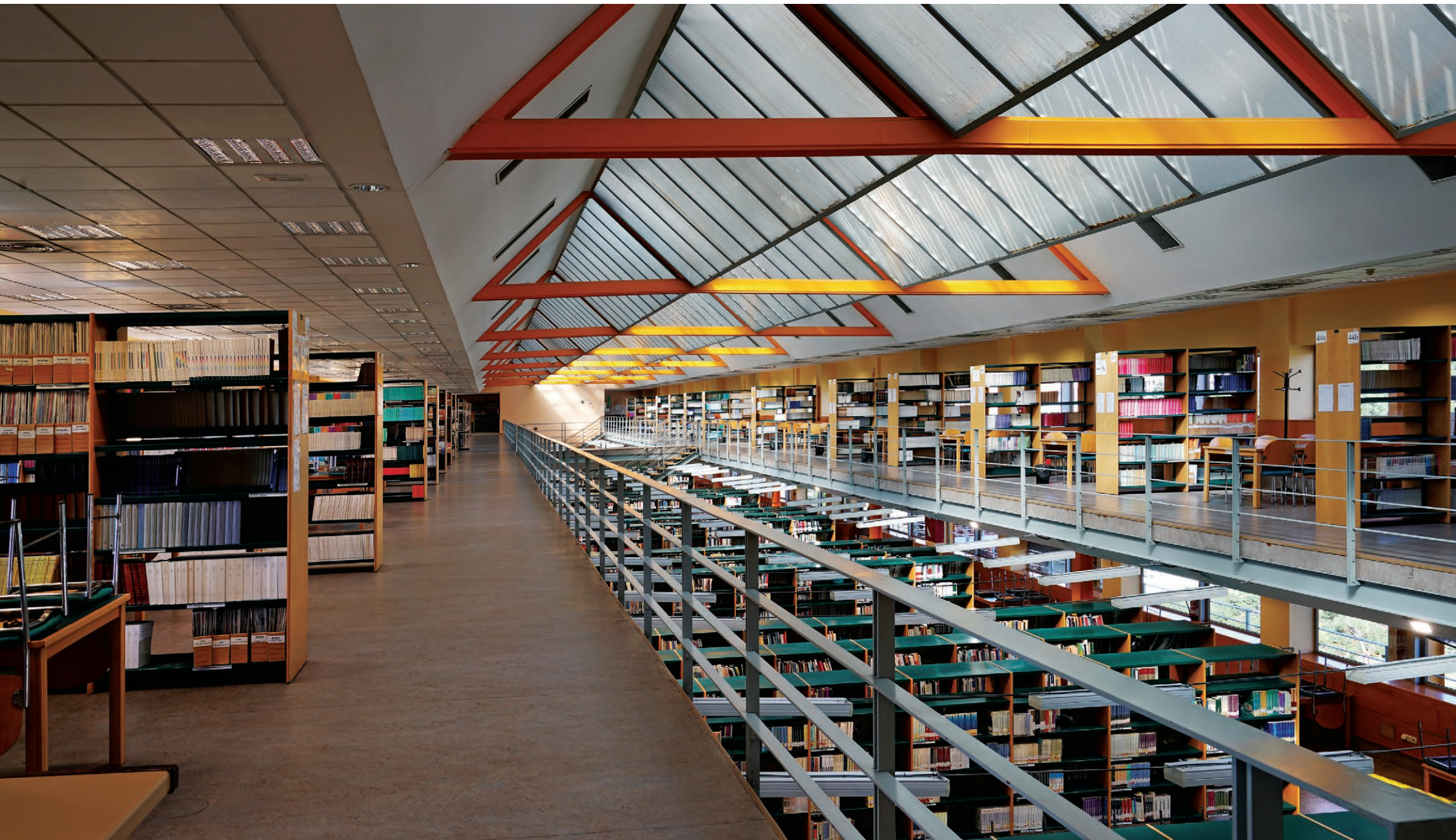
^ La sala de lectura se configura como un espacio único soportado por cerchas triangulares y recorrido por un gran lucernario.
