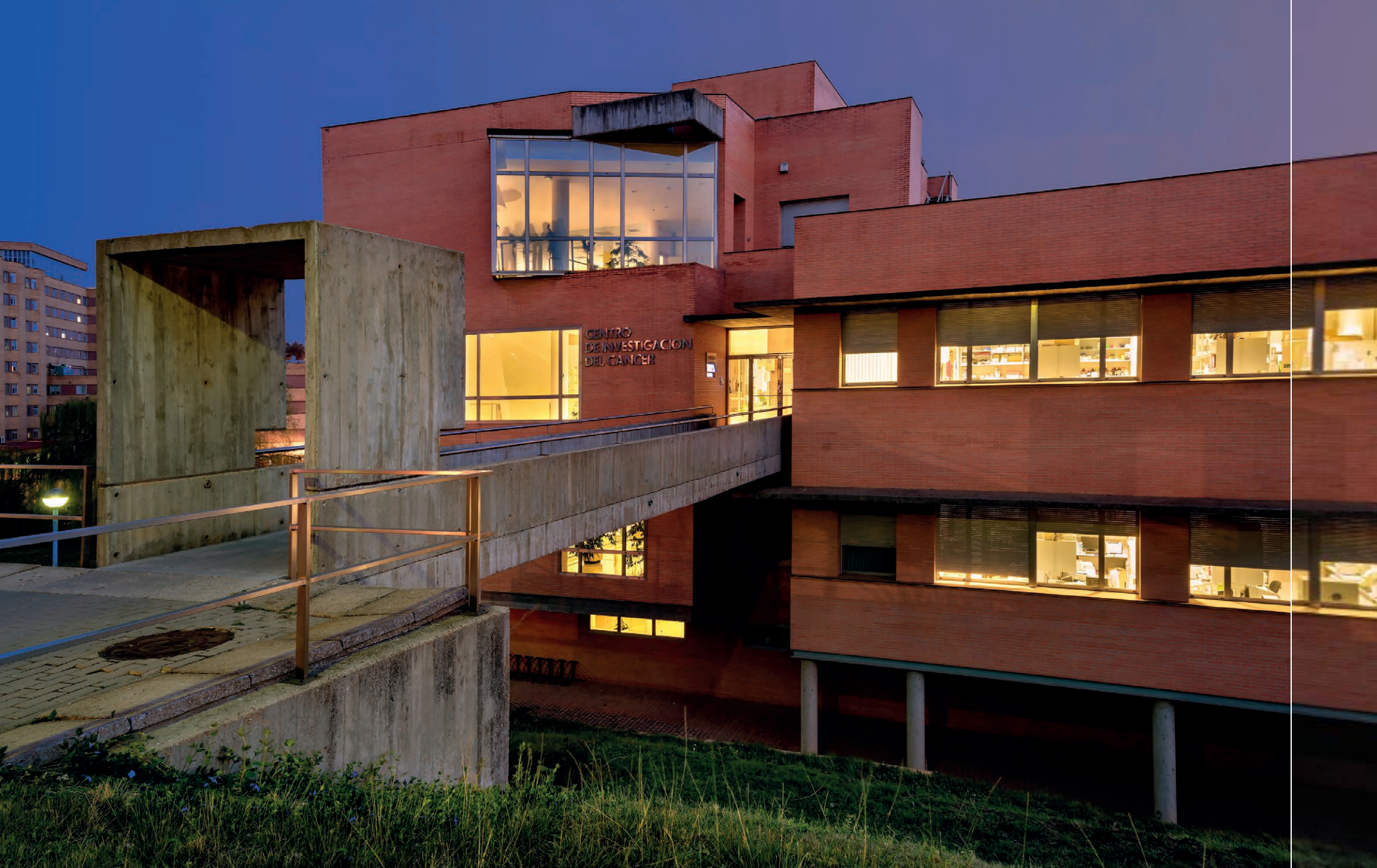
^ Pasarela de hormigón entre la plaza ajardinada y el tercer piso del cuerpo norte, de acusada complejidad geométrica.
