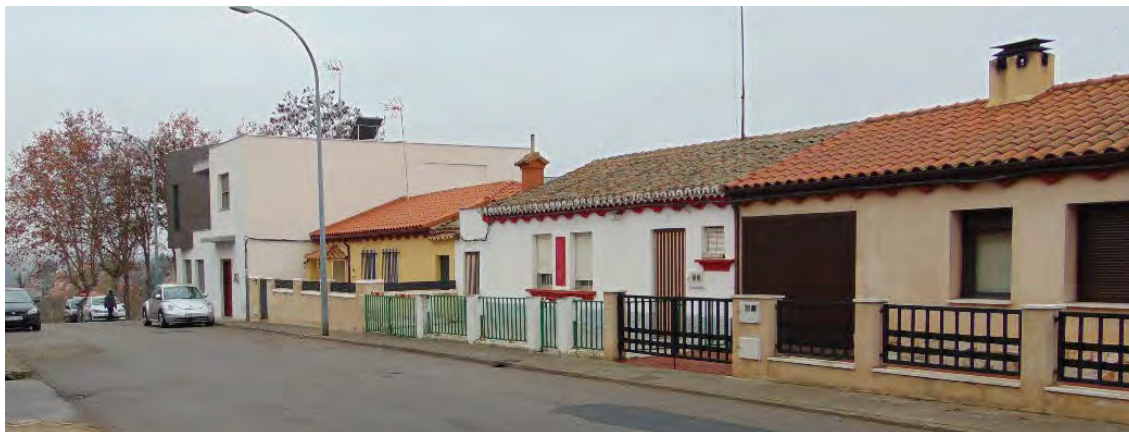
Figura 197. Vista de la calle Santa Susana. Al fondo se advierte una nueva construcción que nada tiene que ver con las características compositivas originales de la colonia.
