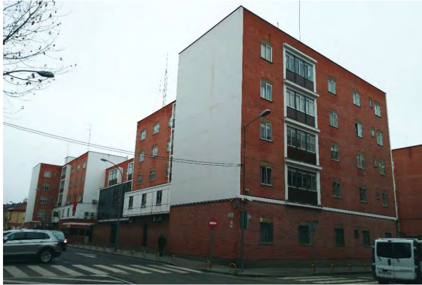
Figura 195. Vista de los bloques del I al V de la casa-cuartel de la Guardia Civil. Fuente propia.
