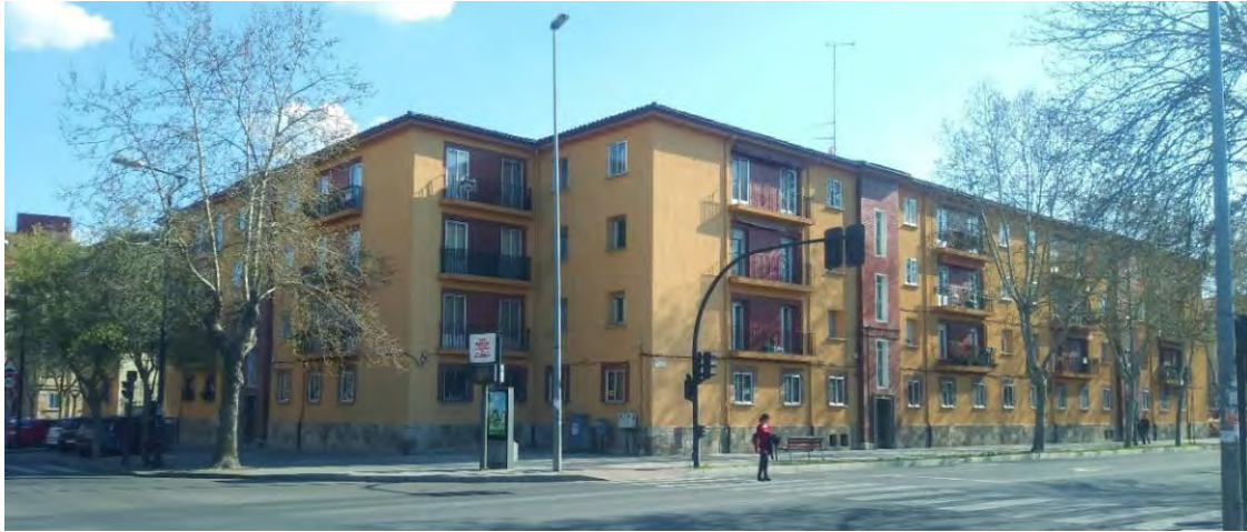
Figura 159. Estado actual del grupo de viviendas José Antonio. Fuente propia.
