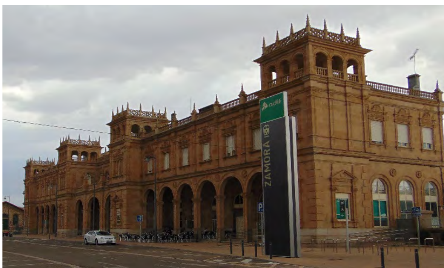
Figuras 10. Estación de Ferrocarril de Zamora. Fuente propia.
