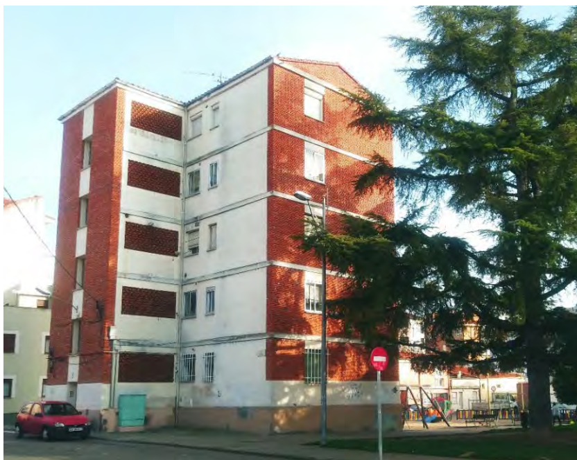
Figura 188. Vista del edificio de viviendas de la calle Aceñas y detalle de la celosís de piezas cerámicas dispuesta en el cerramiento de las terrazas.
