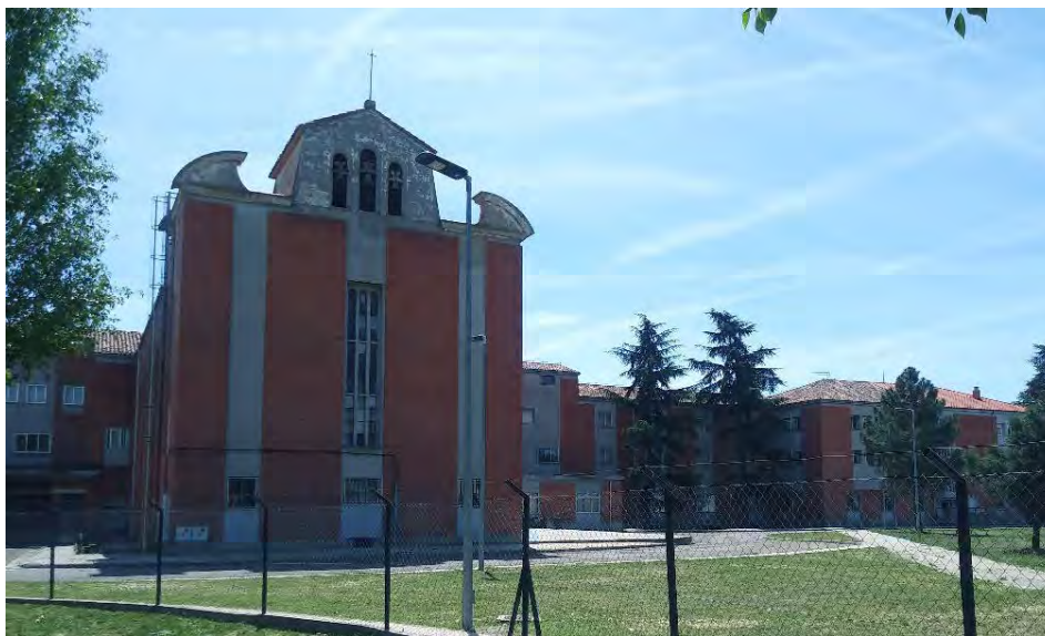
Figura 85. Vista del pabellón central de la Residencia Provincial. Fuente propia.
