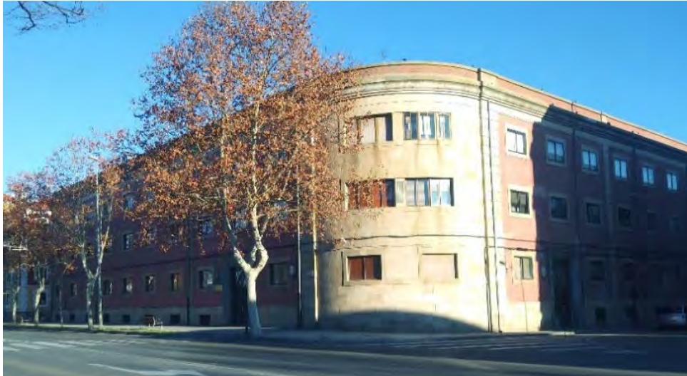
Figura 145. Imagen de la rotonda de la residencia para suboficiales solteros. Fuente propia.
