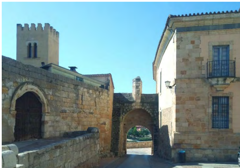
Figura 32. Imagen del estado actual de la puerta del Obispo. La estructura se apoya en la Casa del Cid (a la izquierda de la imagen) y en el Palacio Episcopal (a la derecha). Fuente propia.
