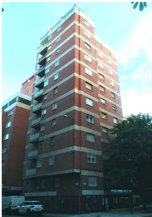
Figura 120. Imagen del edificio de viviendas situado en la esquina entre la calle Regimiento de Toledo y avenida Príncipe de Asturias, proyectado por Gabriel Riesco Fernández en 1966. Fuente propia.
