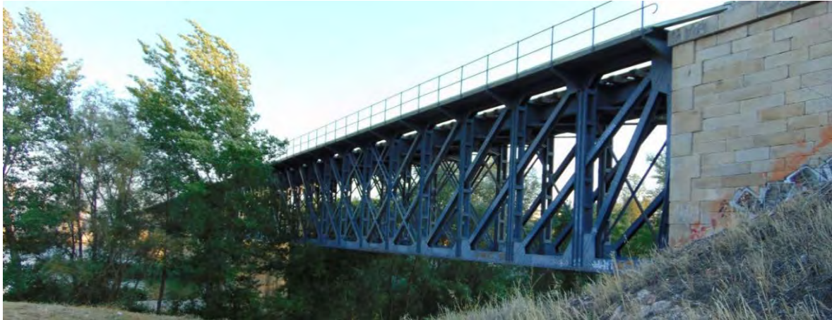
Figura 11. Puente del ferrocarril de la línea Plasencia-Astorga. Fuente propia.
