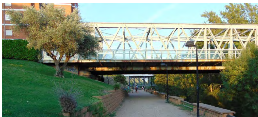
Figuras 4 y 5. Puente de hierro sobre el Duero. Fuente propia.
