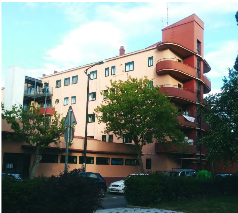
Figura 152. Vista actual de la fachada a la avenida de los Reyes Católicos del grupo de viviendas Ramiro Ledesma. Fuente propia.
