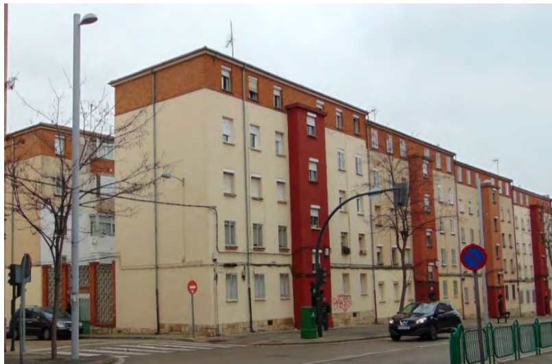
Figura 169. Edificio de la primera fase del grupo Manuel Mateos. Fuente propia.
