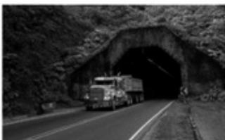
**El Túnel Zurquí es el más grande de Costa Rica, este túnel fue construido dentro de una montaña con el fin de conectar la provincia de San José con la de Limón, con una altura de 10 m y 12 m de ancho, el Ministerio de Obras Públicas desea saber cuál es la máxima altura que puede ingresar un vehículo para que pueda transitar y no tenga problemas en chocar contra el túnel o contra otro vehículo.**
