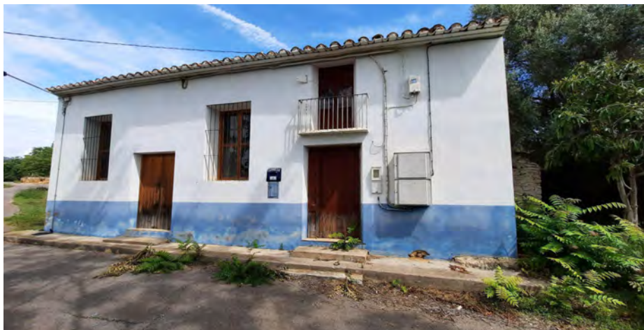
IMAGEN 1. Fachada principal de la escuela del Mas d'en Ramona.
