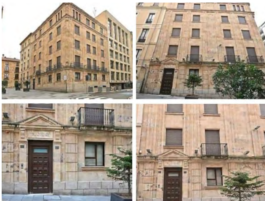
IMAGEN 4. Fotos actuales del Edificio Calonge.
