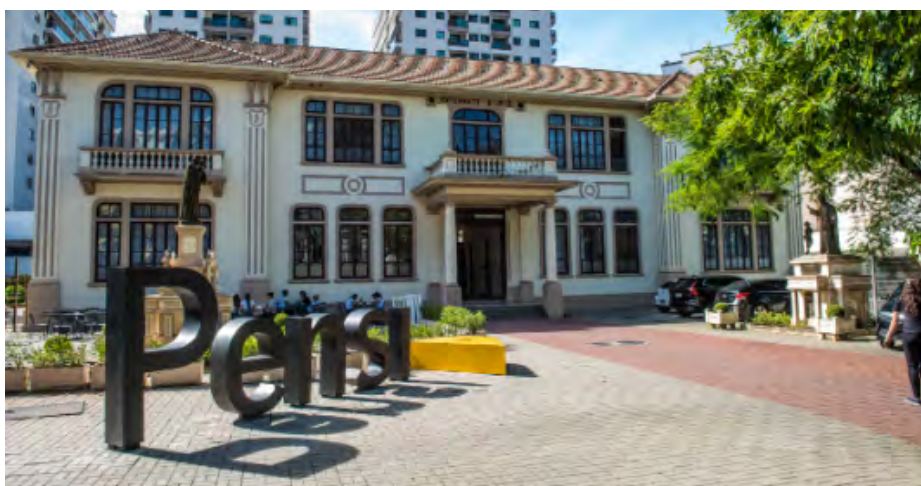
IMAGEM 1. Fachada do prédio tombado do Colégio Marista São José, atual endereço do Colégio Pensi (rua Barão de Mesquita, número 164).
